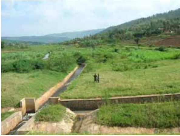
Confluence du déversoir et le canal principal
