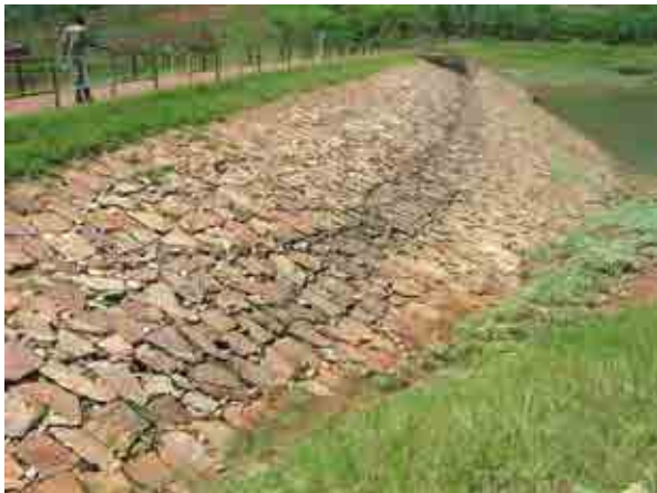
Enrochement sur la pente amont
