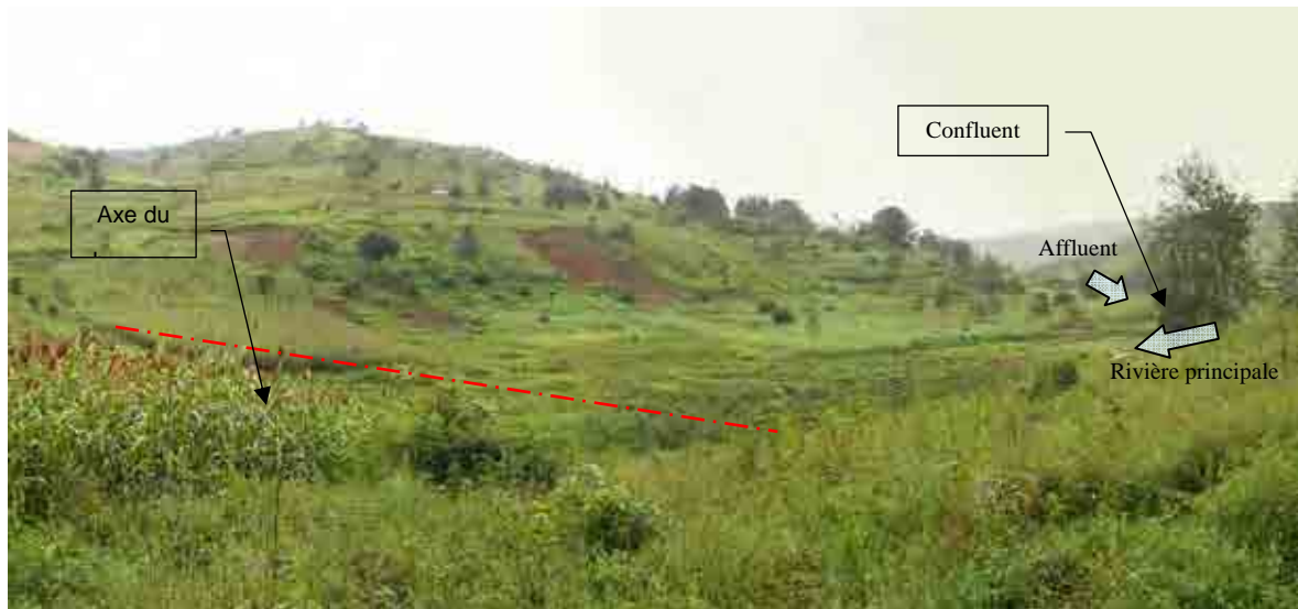
Vue de la rive gauche à l'axe du barrage à la zone du bassin de réception
