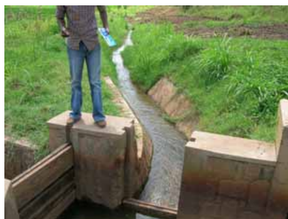
Ouvrage de distribution (à droite : canal principal)
