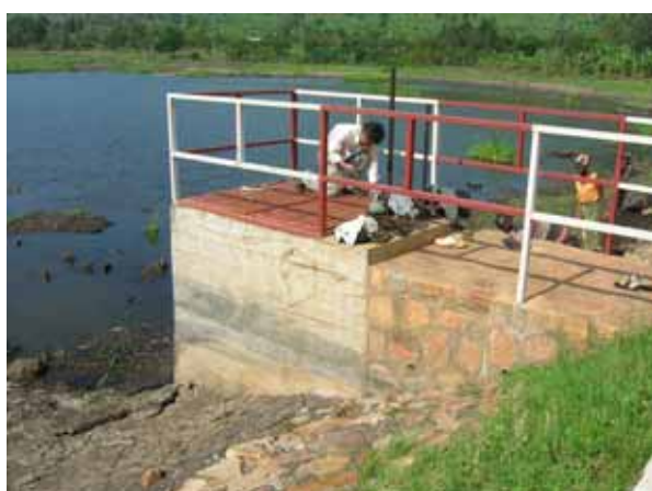
Prise d'eau (portion d'entrée) (Rejet lorsque le niveau d'eau approche la limite d'un mètre sous ligne de crête)
