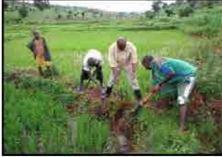
Réparation de diguettes
