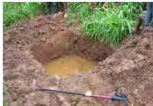
15. Eau dans le puits de sondage No.2
