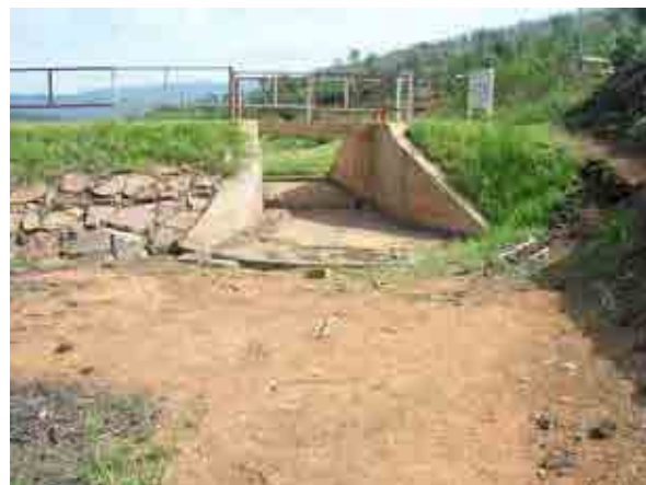
Entrée du déversoir (nappe déversante en avril et en novembre)
