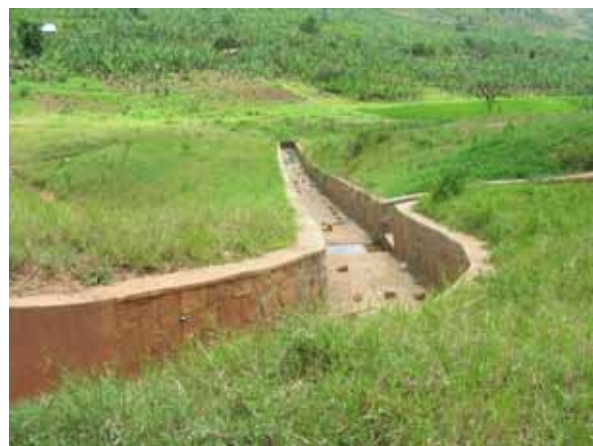
Partie de chute du déversoir
