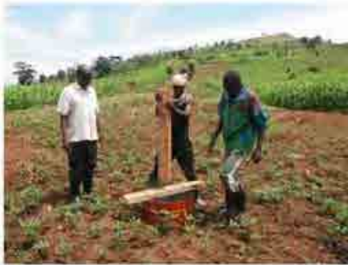
Mise en place d'un cadre rond destiné à un étang
