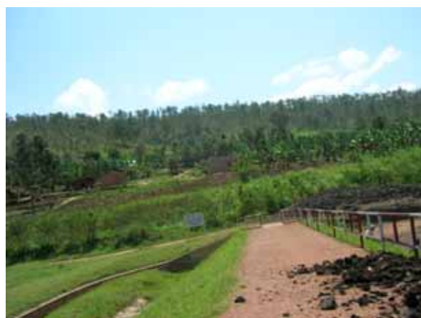
Barrage ( Crête du barrage - Côté rive droite )
