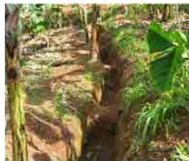
2. Ouvrages de collecte des eaux de surface à la plantation bananière
