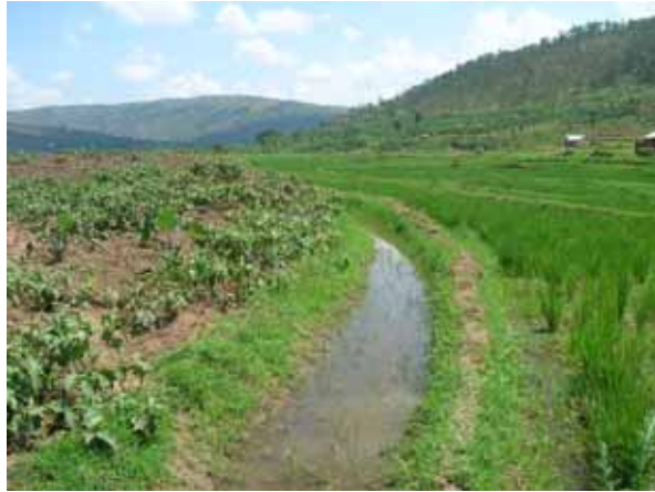
Canal principal traversant la zone bénéficiaire en aval
