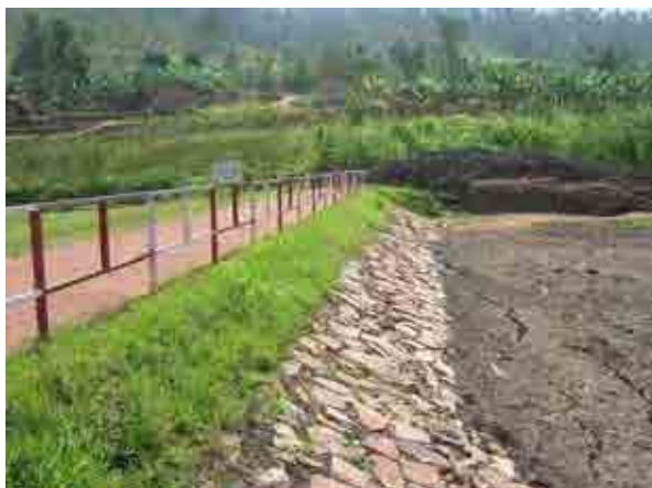
Enrochement sur la pente amont
