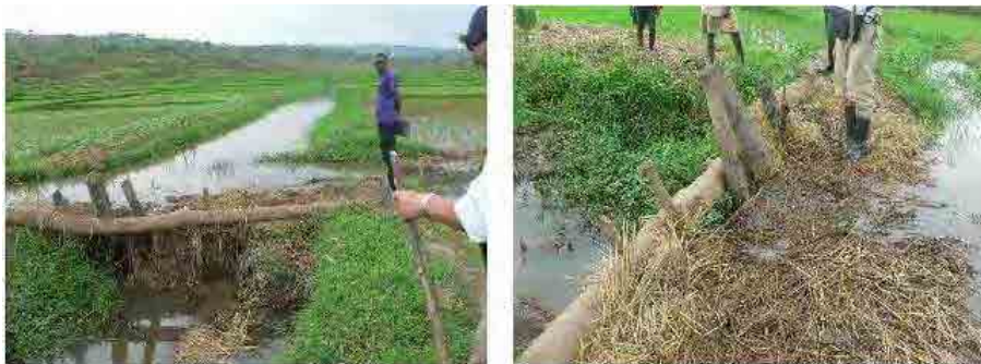
(e) Situation en aval du confluent
