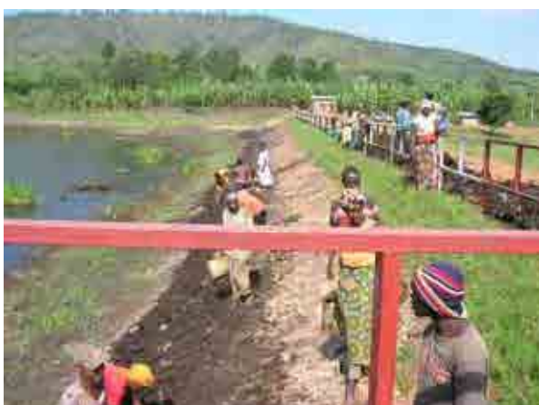
Barrage ( Crête du barrage - Côté rive gauche)
