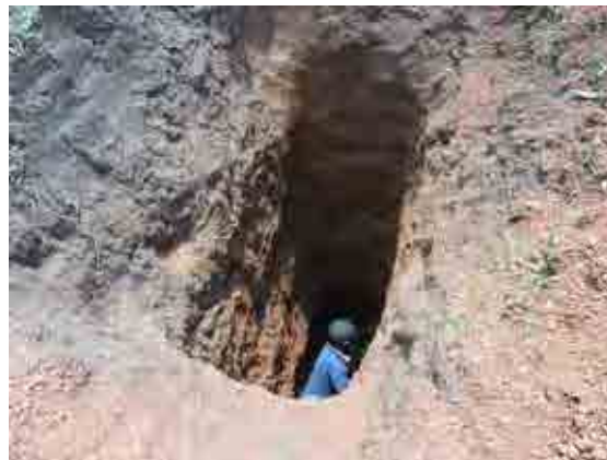
Creusement d'un puits de sondage (diamètre: D = 4,9 m)
