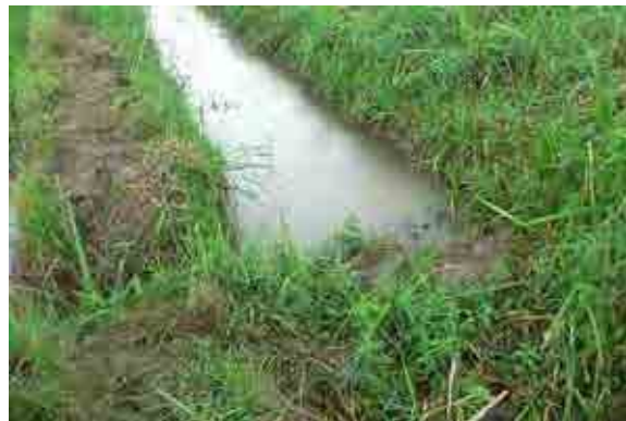
Fin de l'amenée côté colline (à 250m en amont du confluent) où la connexion avec le réseau de la vallée du barrage chinois est coupée
