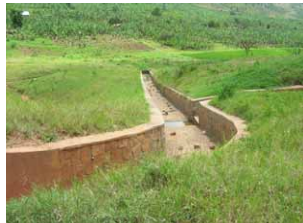
Spillway • chute canal
