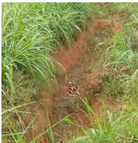
右岸アバット斜面上の雨水流下遮断工
