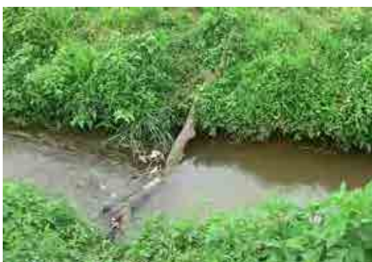
下流約500m地点のせき上げ用横木
