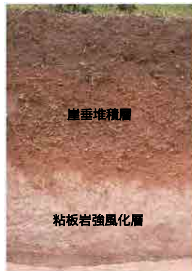
左岸上流改修道路切り土面に現れた崖垂堆積層
