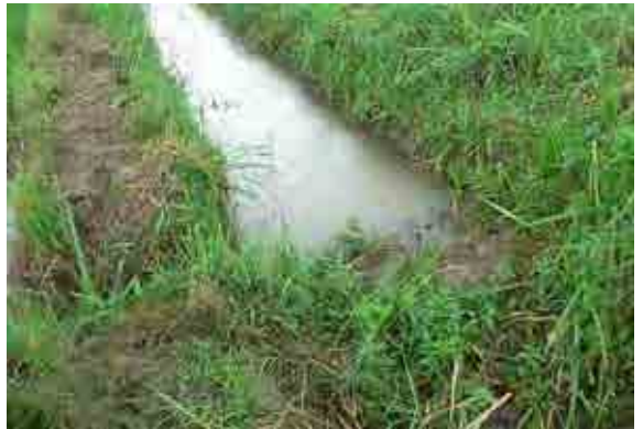
山側水路の終点（合流点上流約250m） (中国ダムの谷系用水路との接続を締め切っている)
