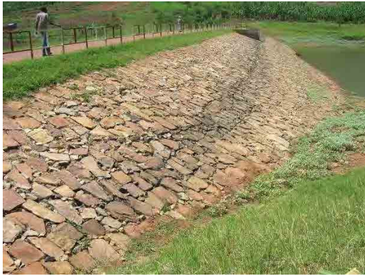
堤体上流斜面保護張り石工
