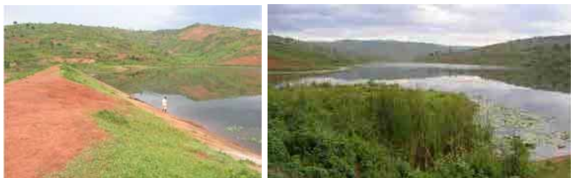
Goshovi 谷の奥にあるダム（堤高約 20m、堤頂長約 200m、所属不明）
