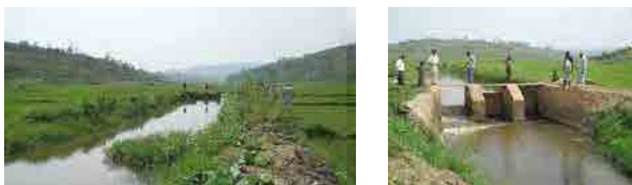
チェックゲートによるせき上げ取水と周囲の水田
