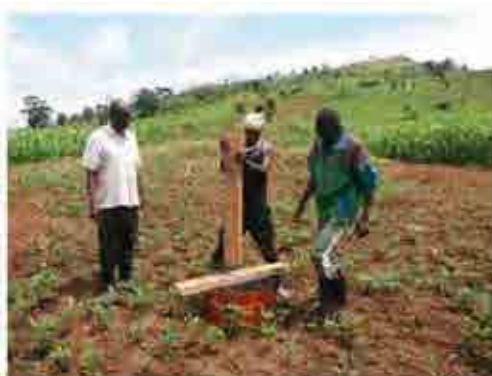
緩衝池用円形枠設置
