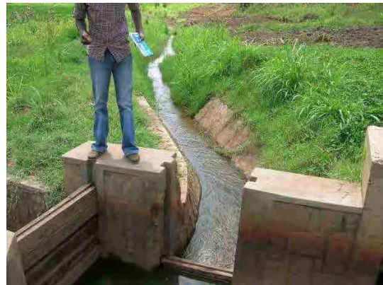
分水工（右岸幹線水路）
