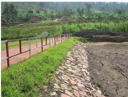
上流斜面保護張り石工
