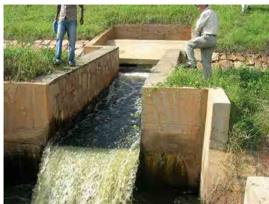
取水工吐き出し口
