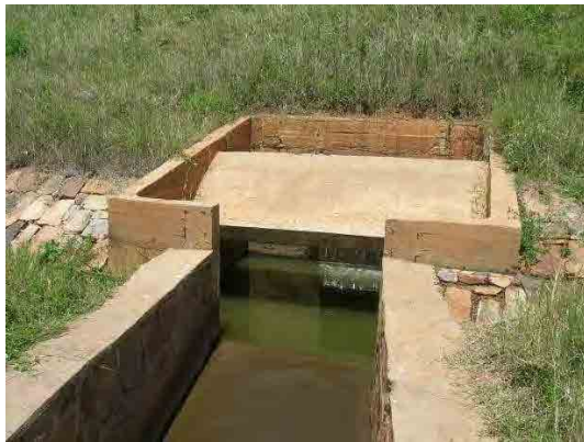
取水工吐き出し口
