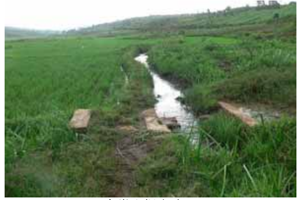
右岸山裾水路。
