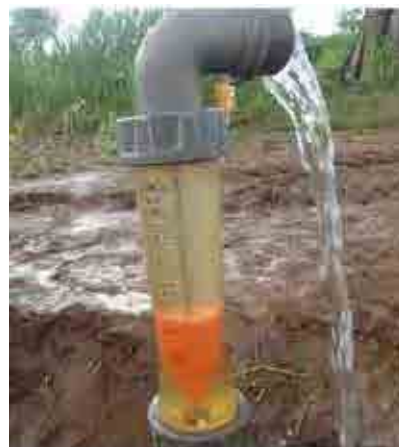
定量揚水試験・揚水状況
