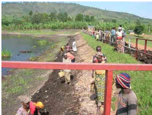
堤体（ダム天端～左岸）
