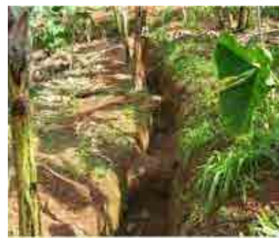
2. バナナ園内の表流水遮断工
