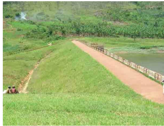
下流斜面保護植生工
