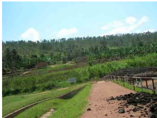
堤体（ダム天端～右岸）
