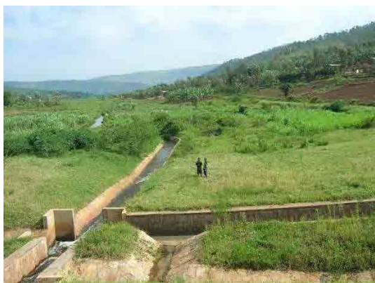
洪水吐の合流と幹線用水路（河川）
