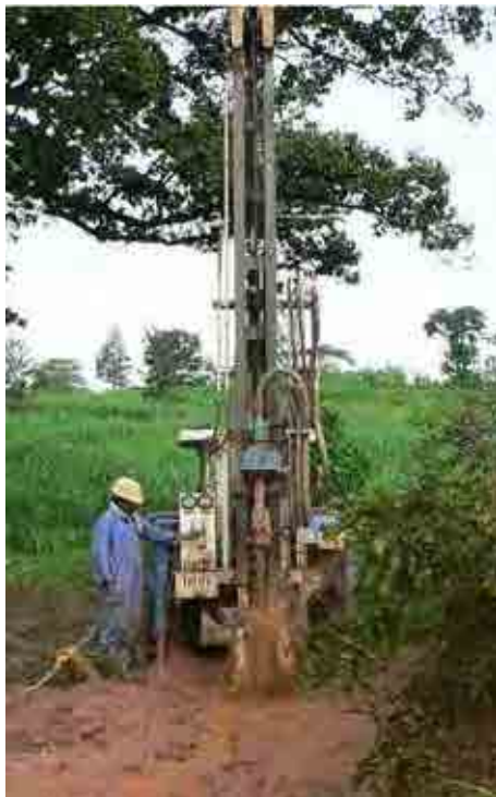
試験孔の削孔状況
