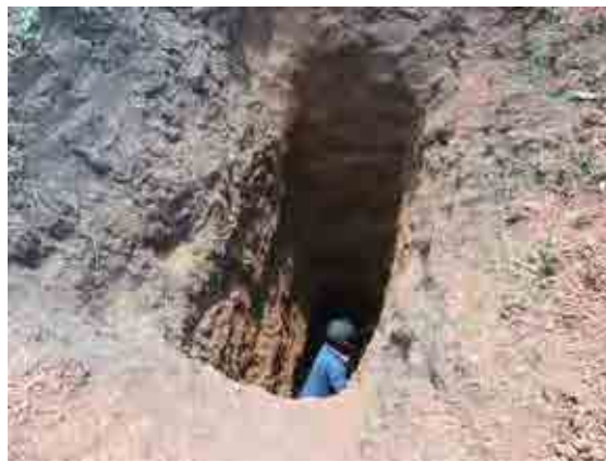
テストピット掘削 (D=4.9m)
