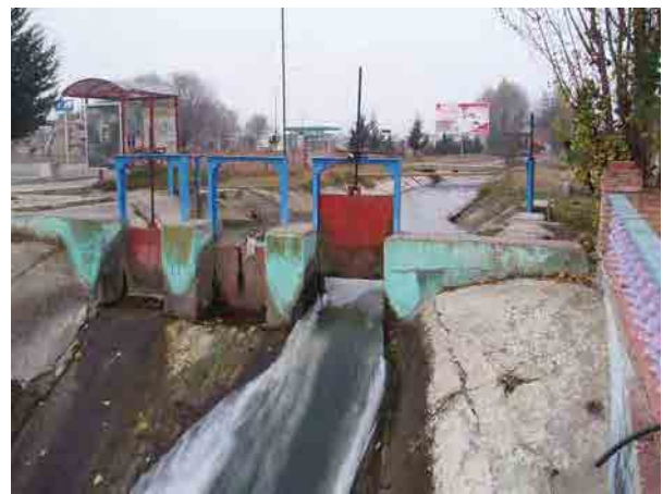
R3用水路。1982年に改修されているが、老朽化が進んでいる。〔ベイラガン地区〕
