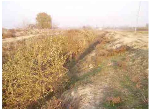
GD902排水路。3年前に堆砂除去を行った。 〔アグジャベディ地区〕
