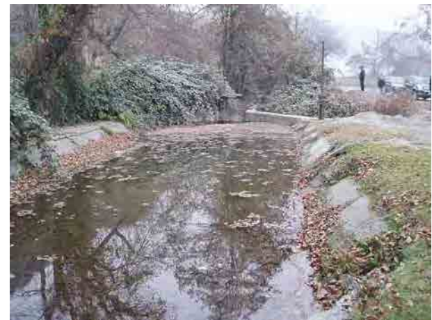
HPS用水路沈砂池。4カ月で1.2mの堆砂。年5～6回清掃〔バラカン地区〕
