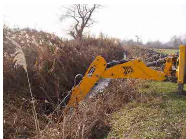
Gumalg Sazarkhak用水路メンテナンス状況。1年前にメンテナンスし、1年で約0.5mの堆砂〔オグズ地区〕
