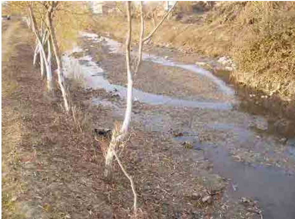
17-1灌漑用水路。堆砂深さ1.0~1.5m 〔アグジャベディ地区〕
