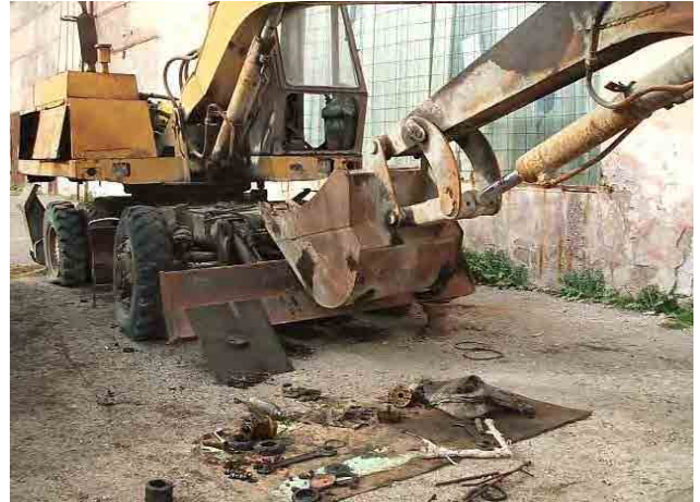
油圧システムの交換工事（照明施設なく屋外作業）
