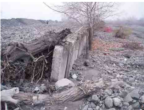
1980年頃に建設された洪水防御壁。河床が4m上昇し、天端まで埋まっている。〔ガハ地区〕
