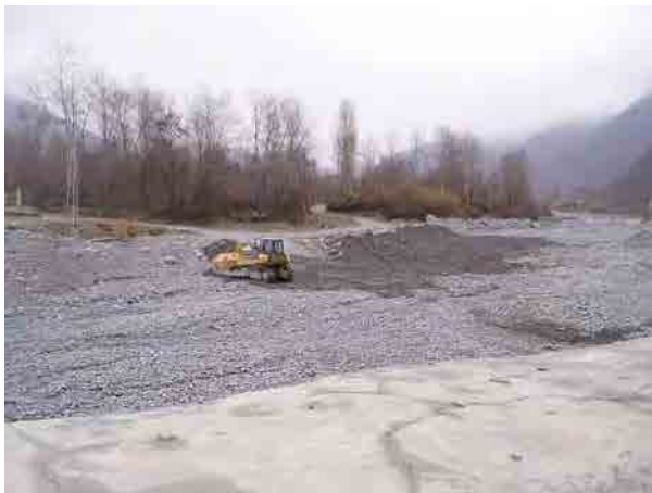
橋梁直上流部でのブルドーザーによる河道掘削状況〔シェキ地区〕
