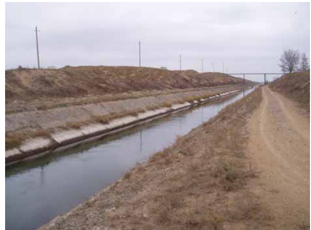
Upper Mil用水路。両側に除去した堆砂が積 み上げられている。〔フズーリ地区〕
