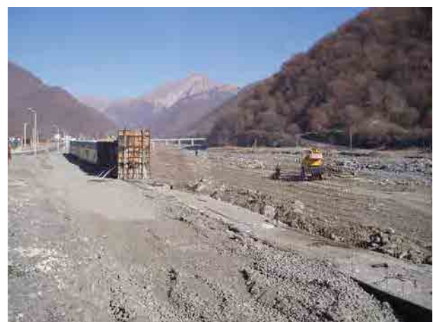
Damiraparan川洪水防御壁建設工事 〔ガバラ地区〕
