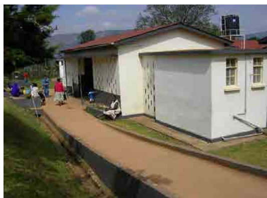
老朽化した既存外来診療棟:本計画の外来・救急棟が完成後に解体され、駐車場・前庭になる予定。
