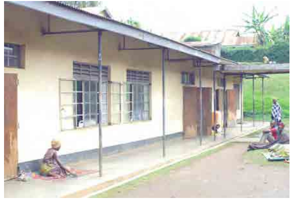
既存手術棟：老朽化しているが、きちんと補修されており、施設の状態は良い。
