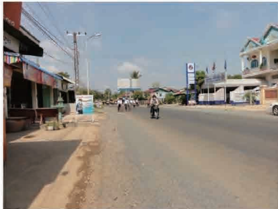
国道5号線市内区間の状況 簡易舗装により仮復旧されているが、 道路排水施設は設置されていない。
