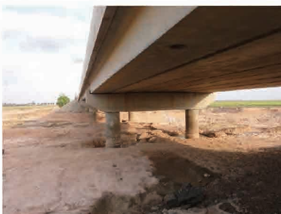
国道8号線の橋梁。すべての橋梁がPCホロー桁形式である。
