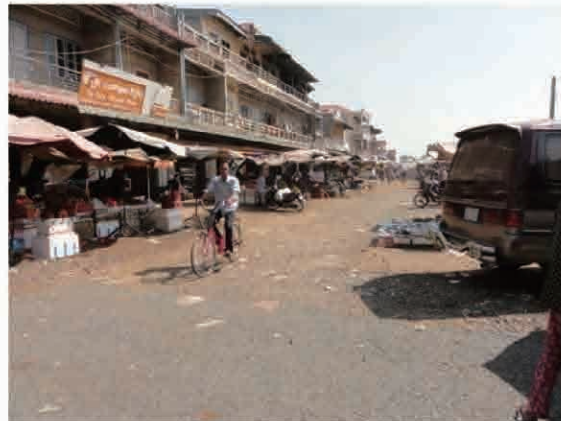
街路の状況 主要な街路以外は舗装復旧されておらず、 排水施設も設置されていない。
