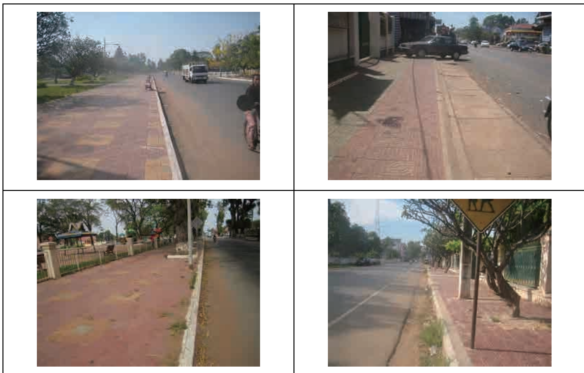
写真 3-2-1 コンポンチュナン市内の既設の歩道舗装
