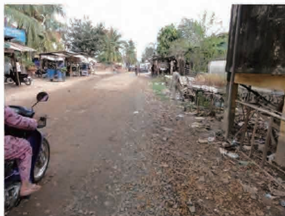
排水路の状況 排水路が整備されていないため 降雨時には道路路肩を排水が流れる。
