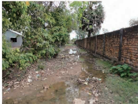
排水路の状況 排水路が整備されていないため 降雨時は道路上を排水が流れる。
