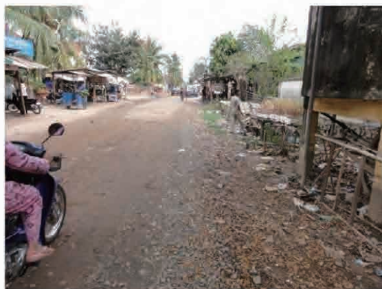
排水路の状況 排水路が整備されていないため 降雨時には道路路肩を排水が流れる。
