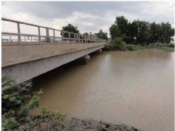
自国資金で改修された国道11号線上のRC-T桁橋。(BR-3)
