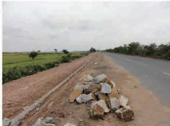
2011年の洪水が越流した国道11号線の越流区間。損傷した法面を石張りにより復旧している。
