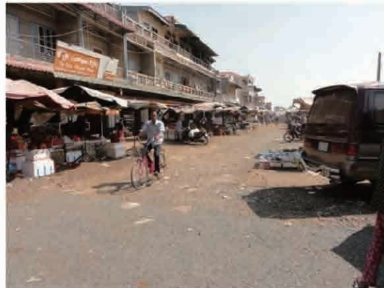
街路の状況 主要な街路以外は舗装復旧されておらず、 排水施設も設置されていない。
