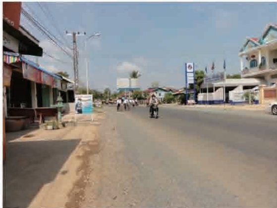
国道5号線市内区間の状況 簡易舗装により仮復旧されているが、 道路排水施設は設置されていない。
