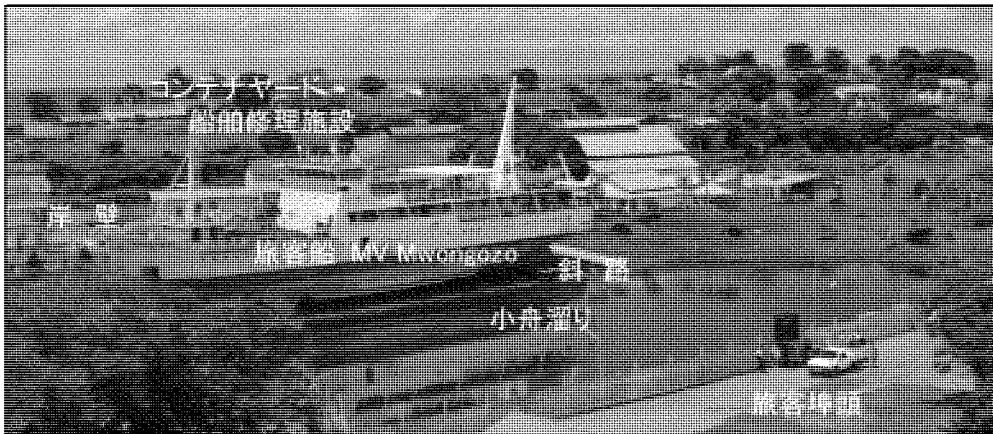
写 2.1.4-3 キゴマ港の船舶修理施設及び小舟溜りの状況
