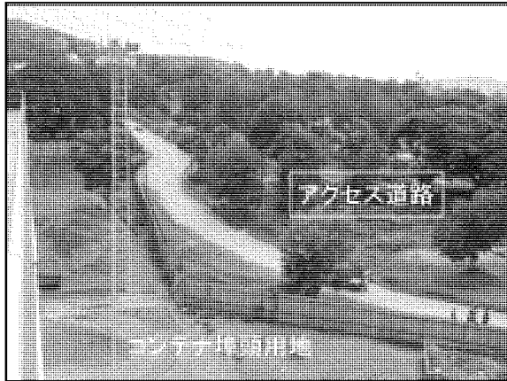
写 2.1.4-8 旅客埠頭付近のアクセス道路の状況
