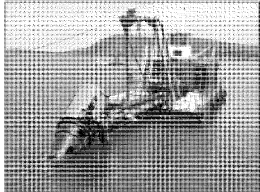
写真-28 キゴマ港で稼働中の浚渫船
