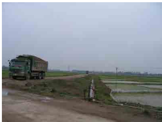
浄水場予定地を横断する道路の様子
