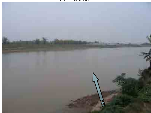
ドン河横断部の様子（南側より撮影）
