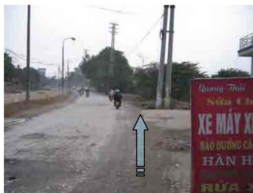
送水管布設予定の道路の様子
