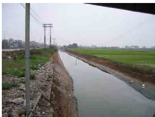
受水点 No.4 への配管は鉄道及び水路を横断する必要があり、非開削工法の採用が必要
