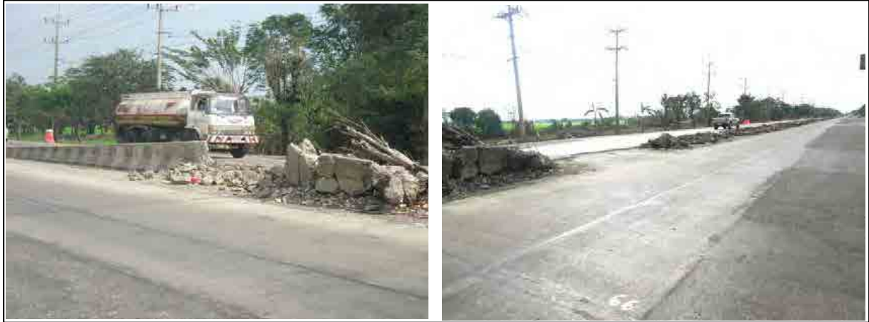
写真 3-2-1-3.1 国道 1 号線中央分離帯コンクリート壁の取り壊し状況
