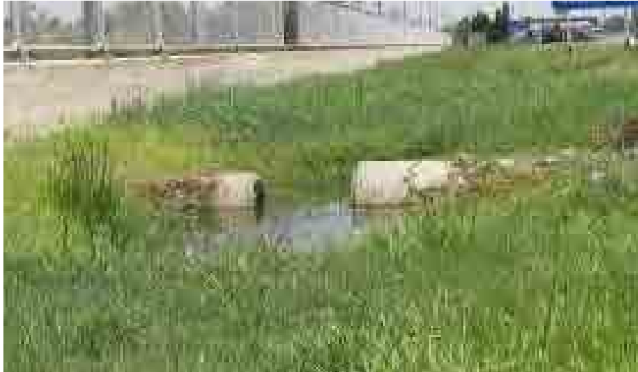
写真 3-2-1-2.2 既存施設の現況調査（境界柵内側設置の自然集水・吐口構造）
