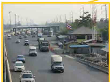
北方向料金所付近全景 Sta.24+875 ~ 25+600
