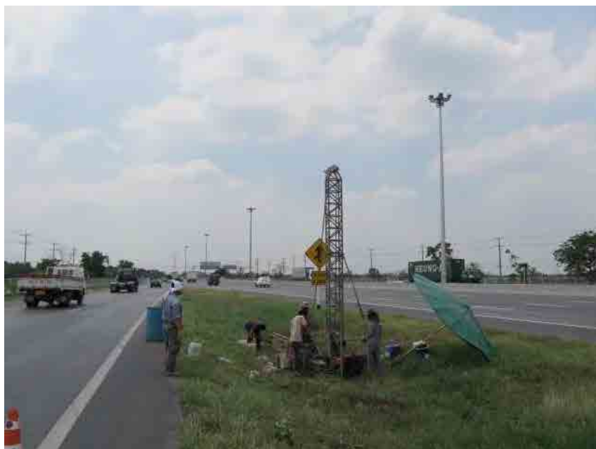
写真 3-2-1-2.1 現場ボーリング試験状況
