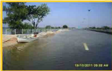
2011年洪水時 対象道路冠水被害状況
