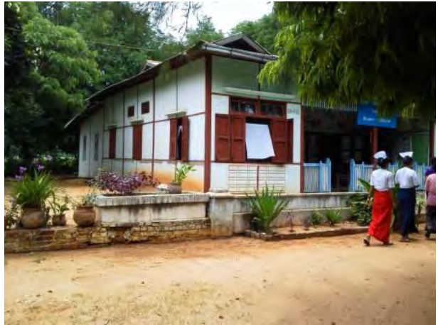
ルーラルヘルスセンター 外観
