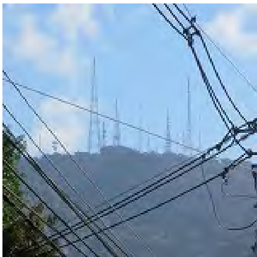
スマレ送信所アンテナ鉄塔
