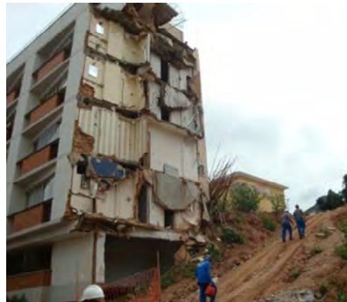
2011/1 土砂崩れでアパートの半分が破壊、死者多数。
