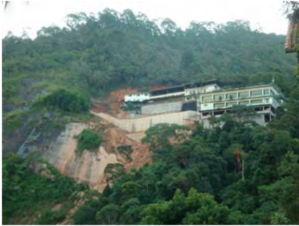
2011/1 豪雨による土砂崩れで 運行中止中の観光用リフト
