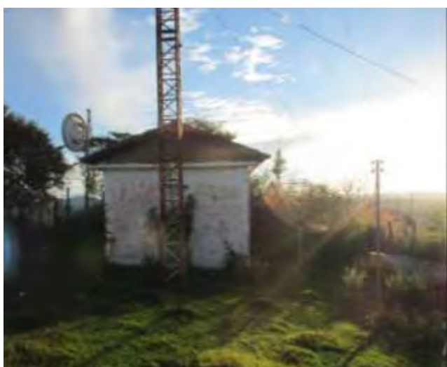
モエダ市営局 送信局舎
