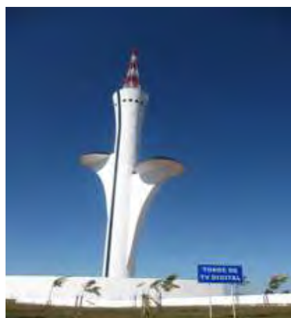
ブラジリア連邦直轄区 共同建築のデジタル送信鉄塔
