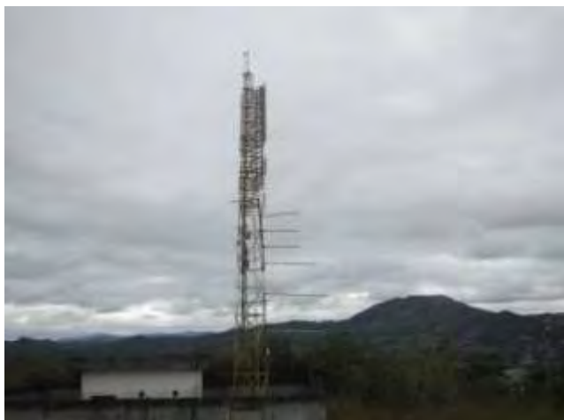
ノバリマ市営局 既設アンテナ鉄塔 (アナログ)
