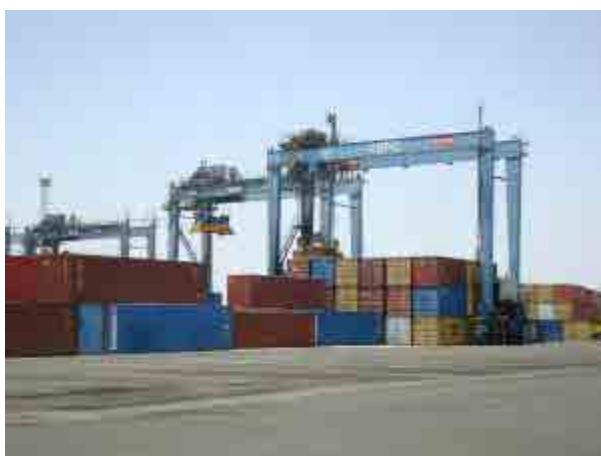
ポーツーダン(North Port)の様子 (調査団撮影)
