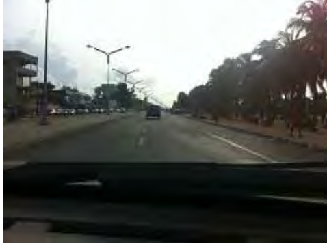
国道2号線（アビジャンーラゴス回廊）
