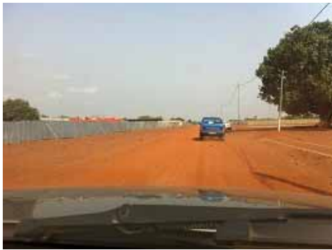
国道17号線（未舗装、締固めのみ）
