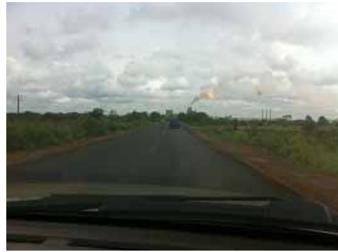
国道4号線（工場付近のみ舗装が新しい）
