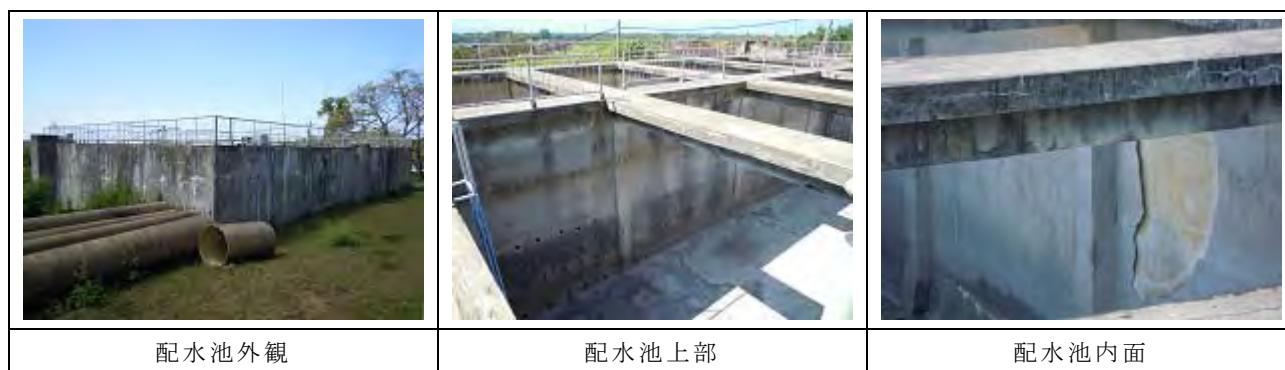
図 8.5.3 既設配水池の現況写真
