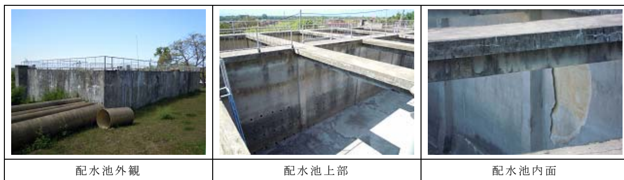
図 8.5.3 既設配水池の現況写真
