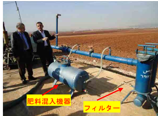
(同左) フィルターと肥料混入機器
