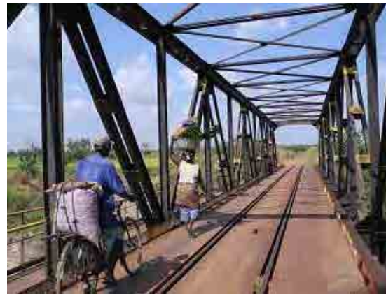
【Haho River付近】左と同じ橋梁であるが、自動車・歩行者が利用していた。
