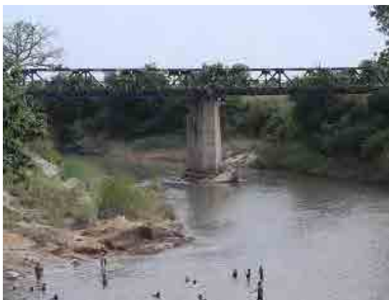
【Anie駅付近】上部工は2径間連続トラスとなっている。
