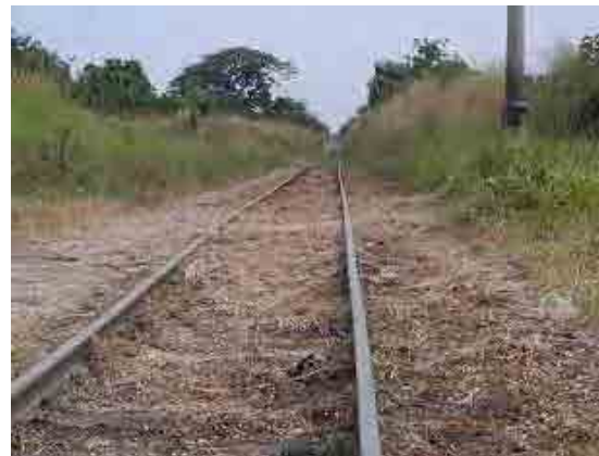
【Anie駅】噴泥化している。レールの通りが不適切
