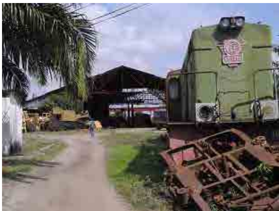
車両工場は建屋が一つ。車両工場内には解体されず放置されたままの廃車が見られた。
