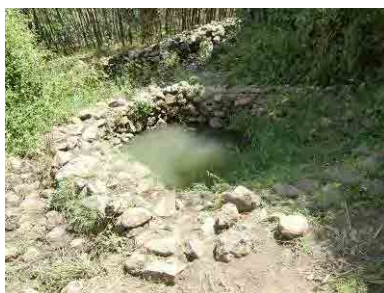
周辺井戸-1 施設建設対象湧水から 400m 下流地点 (飲み水に用いられている)
