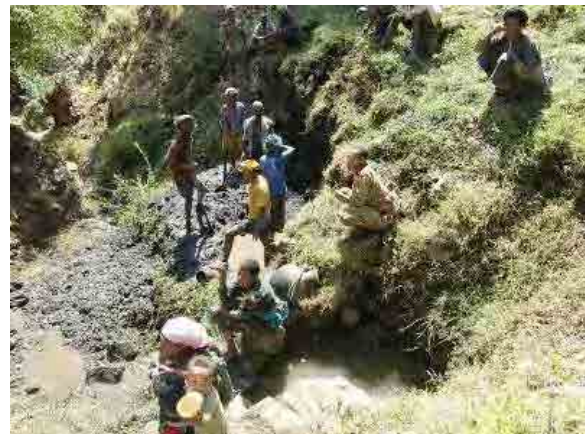
建設に先立ち、サイトの整地が流域住民の手により実施された。
