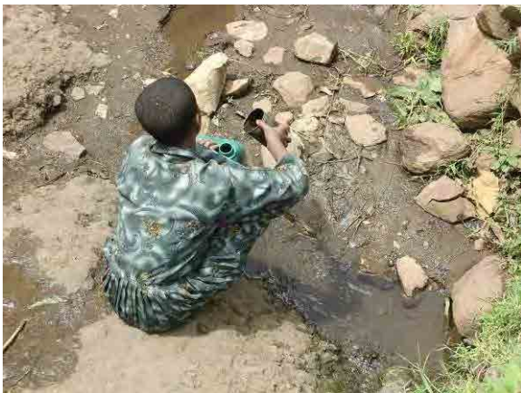
湧水集水施設建設対象の湧水は飲み水として用いられている。
