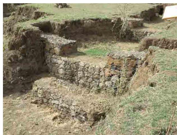
Ebinate ワレダで 2009 年に造られた砂防ダム(蛇かご)には、既に土砂が堆積している。
