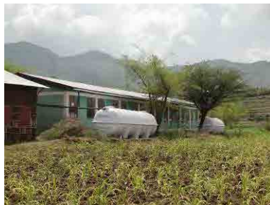
校舎の背後に設置された水タンク
