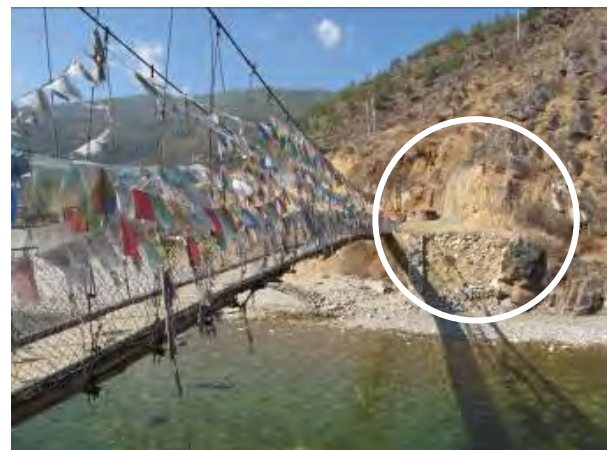
パロ県シャバのつり橋に隣接するベイリー橋の橋台跡(円内)
