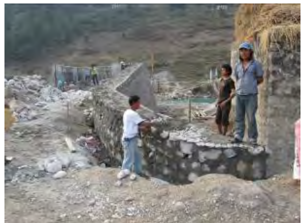
プナカ県の Feeder Road にかかる橋梁建設現場
