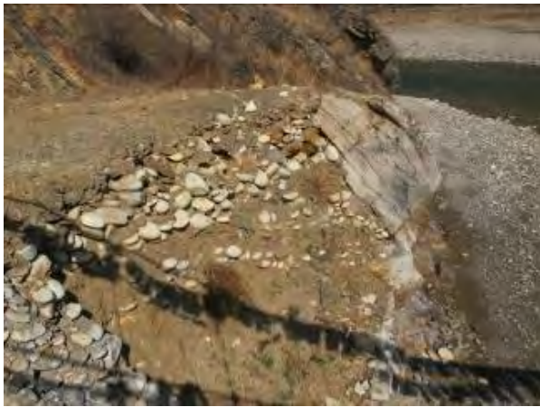
崩壊した左岸橋台
