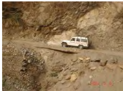
右岸側は切り立った断崖、取付道路の勾配も急
