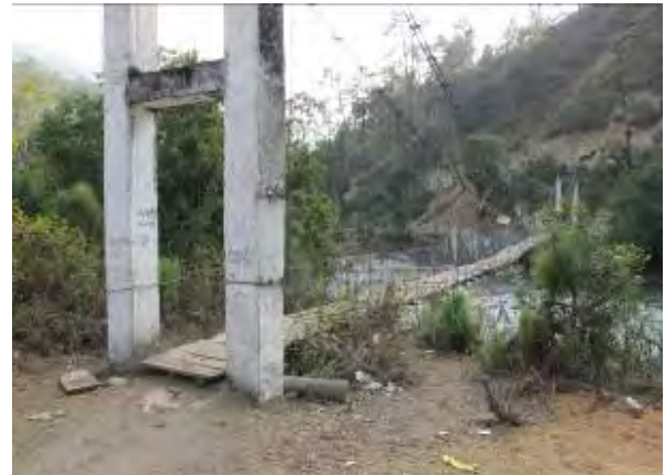
Woolathang-Tshachupu 単スパンのベイリー橋のモデル橋候補サイトの 1 つだが、川幅 60m でやや長い
