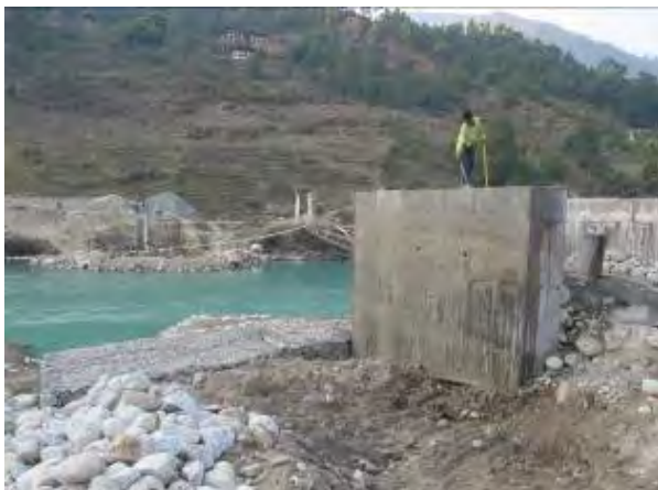
プナカ県の Feeder Road にかかるベイリー橋建 設現場
