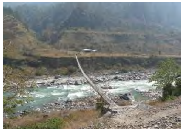
Harazam-Lawa 無償資金協力「第 3 次橋梁架け替え計画」と同じ 国道沿いだが、川幅 125m でモデル橋範疇外
