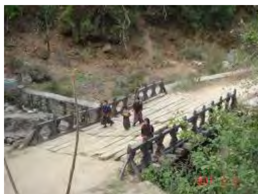
木製の床版（橋長 L=約 10m）
