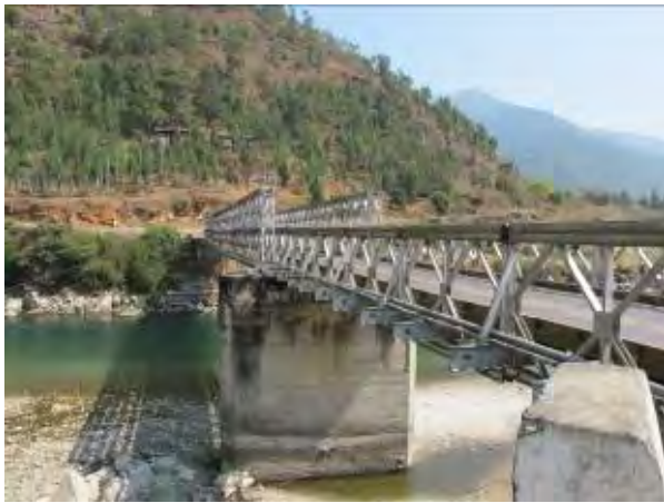
プナカ県の国道にかかる2スパンベイリー橋
