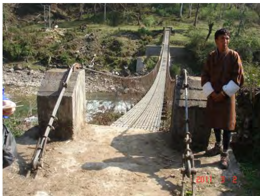
現況の歩道橋（引っ張り橋）
