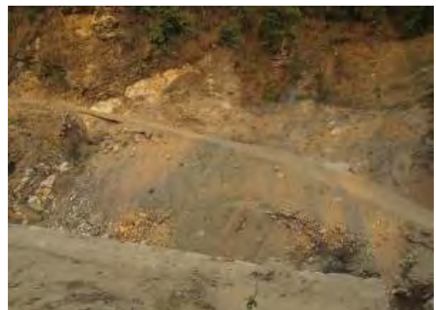
Changhey(1) 対岸で崖崩れが発生して橋台が流出し撤去され た状態、川幅 30m だが、崖崩れの危険性もあり モデル橋としては困難
