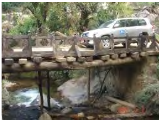
めくれ上がった床版（橋高 H=約 2m）
