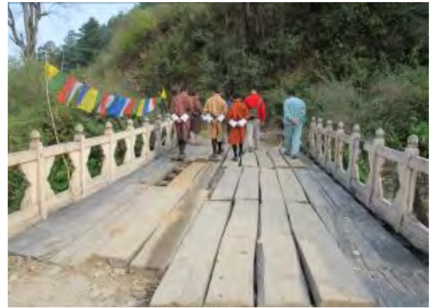
Hamche-Eusaguom 短いコンクリート橋のモデル橋候補サイトの 1 つで、橋長 10m 程度
