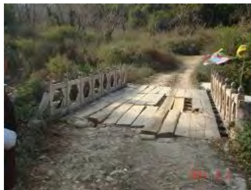
木製の床版（橋長 L=約 10m）
