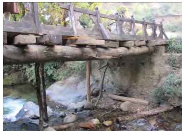
Nahizam-Tashitsawa 短いコンクリート橋のモデル橋候補サイトの 1 つで、橋長 10m 程度
