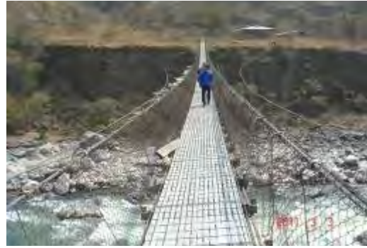
耐風索がしっかり張られ安定した構造
