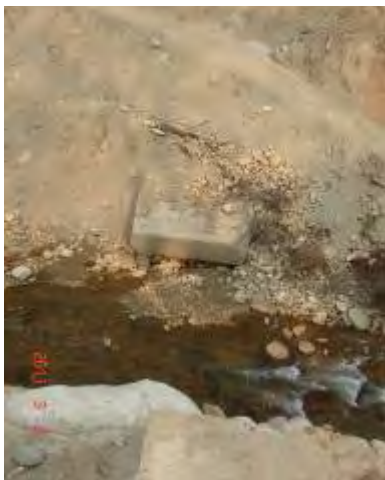
手前は H=10m の左岸アバット、中央は倒壊した右岸アバット
