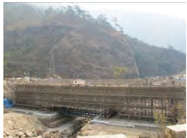
第3次橋梁架け替え計画施工状況
