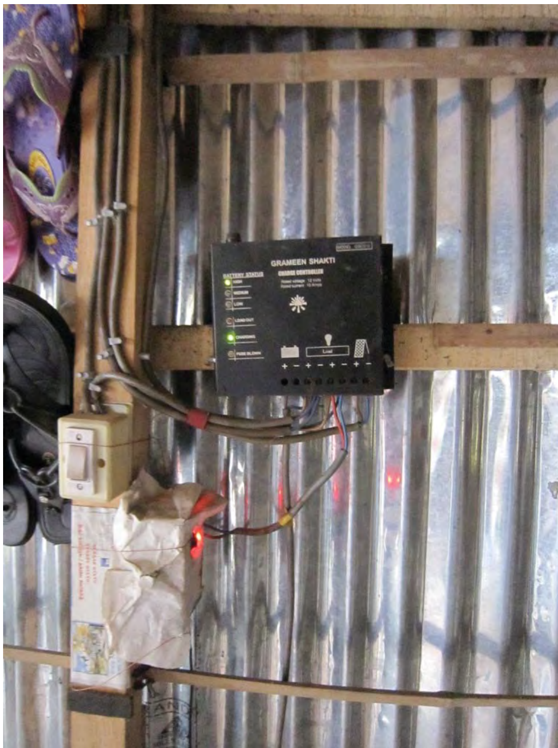
図 17: GS 製チャージコントローラーのマイクロユーティリティでの使用例(分電)
