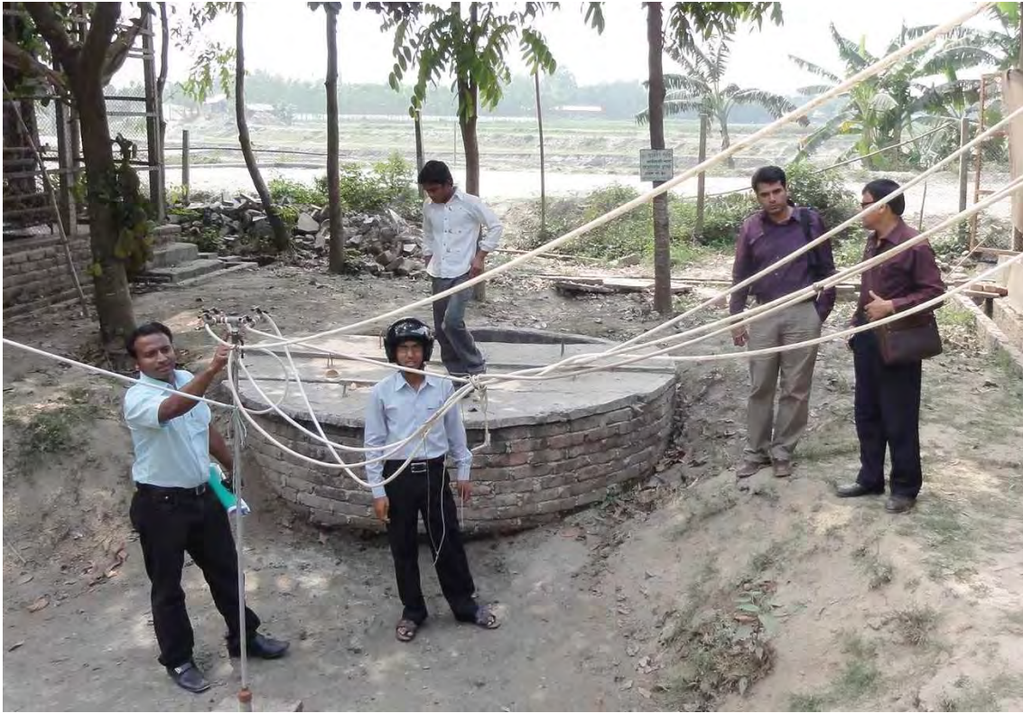
図 22: マイクロユーティリティ用に多数のチューブが接続されているダイジェスター
