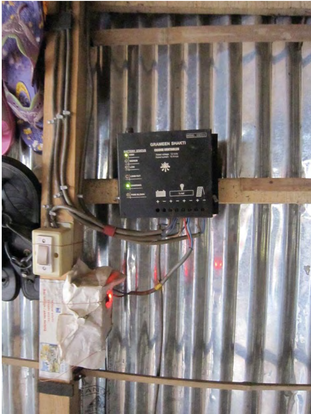
図 17: GS 製チャージコントローラーのマイクロユティリティでの使用例(分電)
