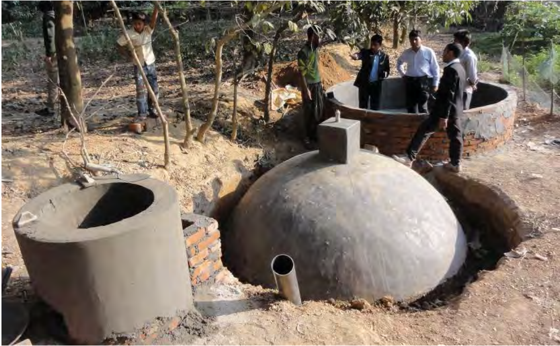
図 21: 建設中のバイオガスダイジェスター
