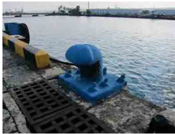
(4) Bollard (inshore side)
