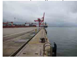
(6) Container Berth-2 (berth line/fender/ladder, etc.)
