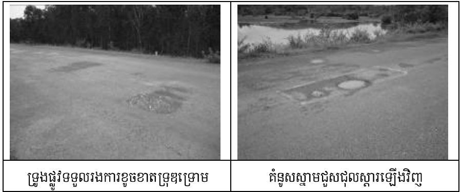
ប្រភព: ក្រុមសិក្សាគម្រោង រូប ២.៤-១១: ទ្រុងផ្លូវខូចខាតទ្រុឌទ្រោម និងការជួសជុលស្ពានឡើងវិញ
