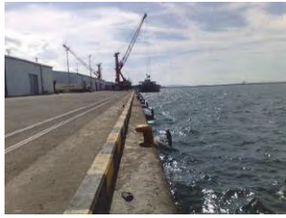
(1) New Quay-1 (quay line)
