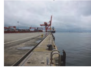
(6) Container Berth-2 (berth line/fender/ladder, etc.)
