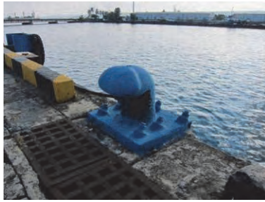
(4) Bollard (inshore side)
