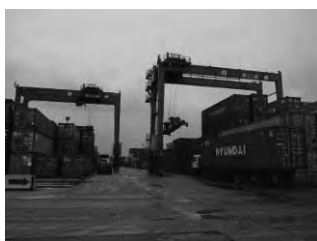
(1) コンテナヤード-1 (RTG & コンテナ基礎/ILB 舗装)
