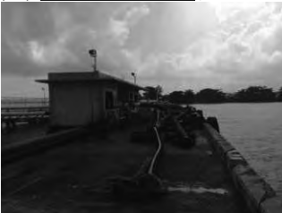
(13) 油送船岸壁-2 (上部工：上面)
