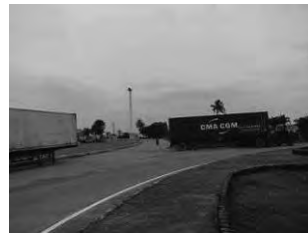
(2) 西側道路-2(ロータリー部)
