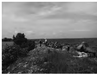
(1) 北防波堤 (北) -1 (原断面と思われる箇所)
