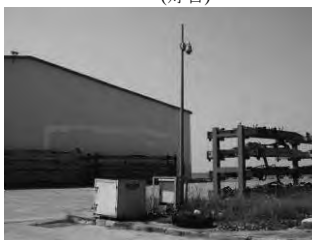
(14) CCTV システム-1 (CCTV カメラ)
