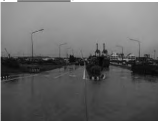
(7) CT 取付道路(ゲート No.3 を望む)
