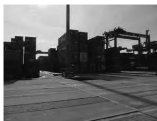
(2) コンテナヤード-2
