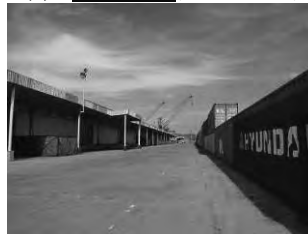
(5) 場内道路-2(倉庫 No.3 背後)
