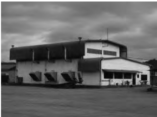
(4) ユーティリティ棟-2 (発電/給電棟)
