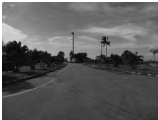
(1) 西側道路-1(AC 舗装部)
