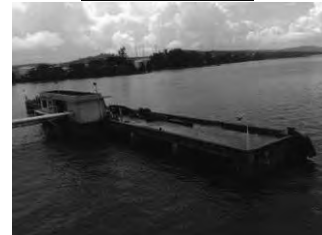
(12) 油送船岸壁-1 (全景)
