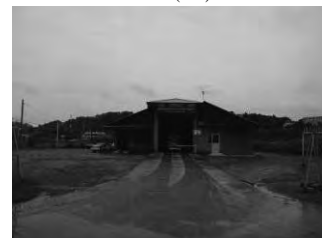
(9) コンテナ検査棟 (RC, ガンマ線検査)
