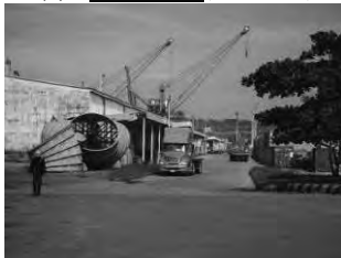
(4) 場内道路-1(倉庫 No.3 背後を望む)
