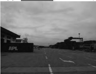
(8) CT 場内道路-1(ILB 舗装部)
