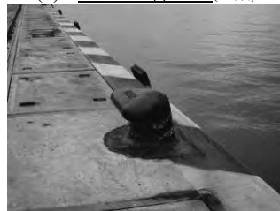
(8) コンテナ岸壁-4 (係船柱)
