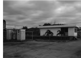
(3) ユーティリティ棟-1 (RC, 機械室)
