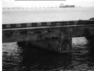
(14) 油送船岸壁-3 (上部工：側面)
