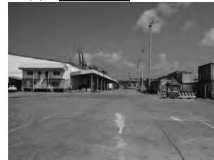
(6) 場内道路-3(倉庫 Nos. 4&5 背後)
