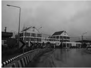
(1) 港湾管理棟 (PAS 事務所塔) (RC)
