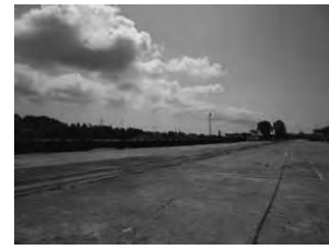
(3) 保管ヤード 1-3 (倉庫 No. 3 背後)
