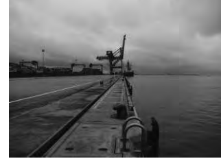
(6) コンテナ岸壁-2 (岸壁法線等)
