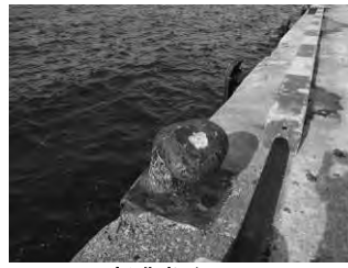
(2) 新港岸壁-2 (係船柱)
