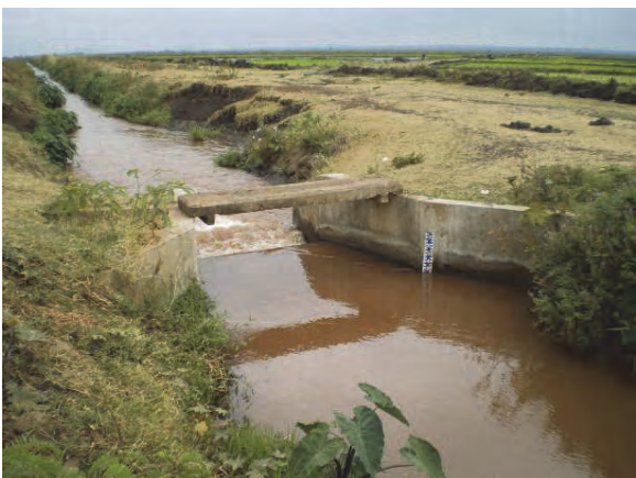
ブランチ水路 3 の量水標。量水標は主要なポイントに設けられている。水路法面の一部に崩落が見られるなど、維持管理が必ずしもゆきとどいていない様子がみられる。
