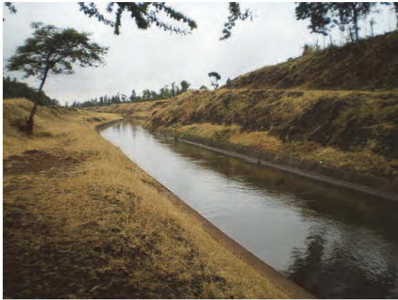
取水堰直下流のリンク水路。きちんと手入れされている印象。
