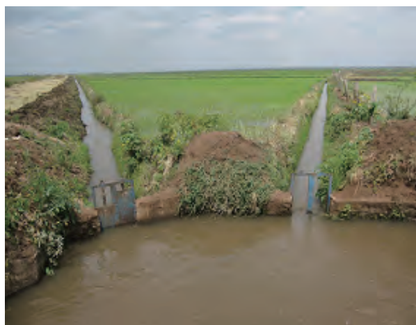
水路の分水 (Branch → Feeder Canal)
