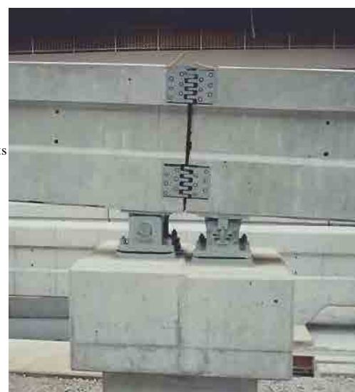
Figura 5-40 Apoios e Juntas de Dilatação (Exemplo)
