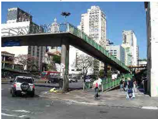
Passarela com rampa
