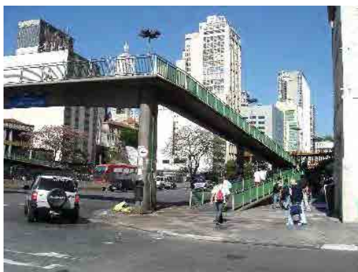
スロープ付歩道橋
