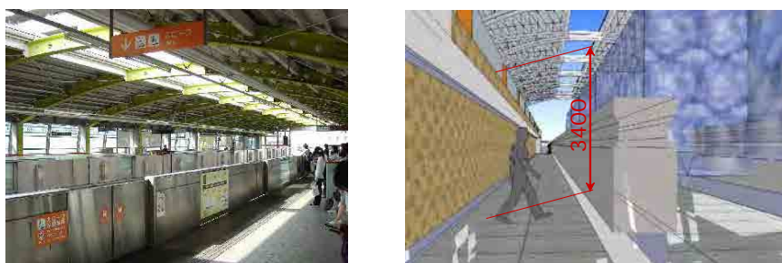
図 5-10 日本の多摩モノレールのプラットホームドアの例
