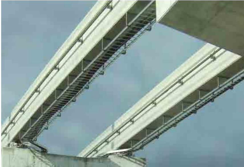
図 6-7 電車線とケーブルトレイ
