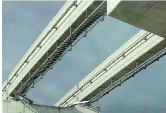
図 1-17 電車線とケーブルトレイ
