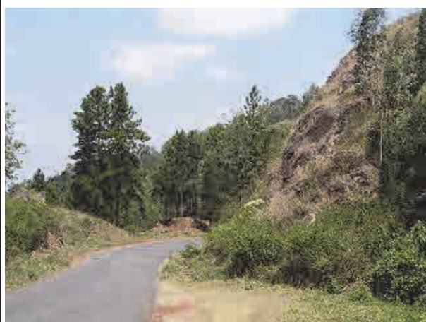
急カーブを改善するため、法面を削った場合、道路改修費が高騰する。交通安全対策を必要とする。
