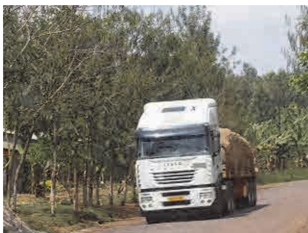
車道幅が狭く、大型車輛の交互交通に際し、安全な走行に支障をきたしている。車道拡幅を行う場合、樹木が支障となる可能性がある。
