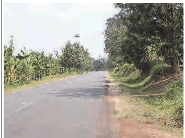
左側は谷のため、右側への片側拡幅の可能性があるが、排水路を含む道路幅は十分にある。
