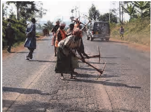
舗装損傷箇所を民間企業が地域住民を雇用し、補修中。
