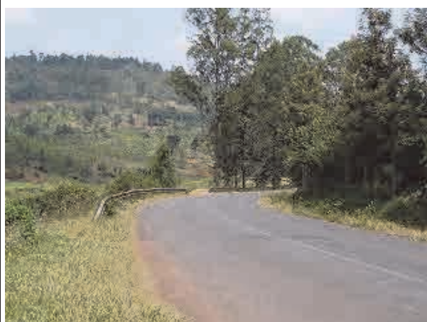
急カーブのため、ガードポストが設置されている。交通安全標識を必要とする。
