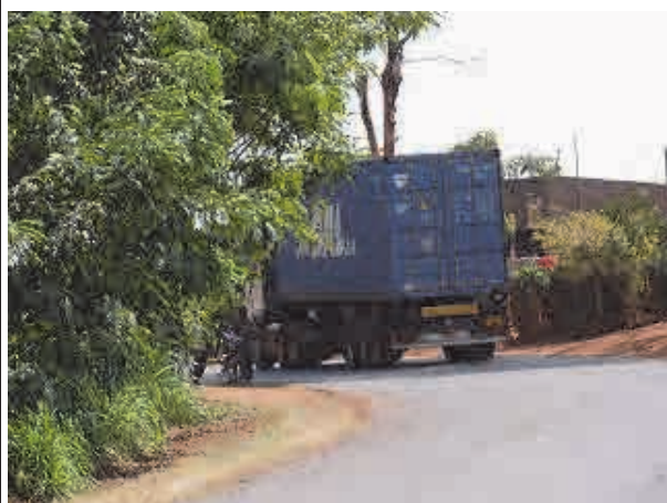
カーブ区間の舗装道路を歩行する地域住民、及び徐行するトラック。交通安全標識・施設を必要とする。
