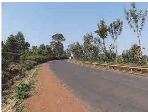
カーブの危険個所にガードレールが設置されている。カーブを安全に曲がるため、交通標識を必要とする。
