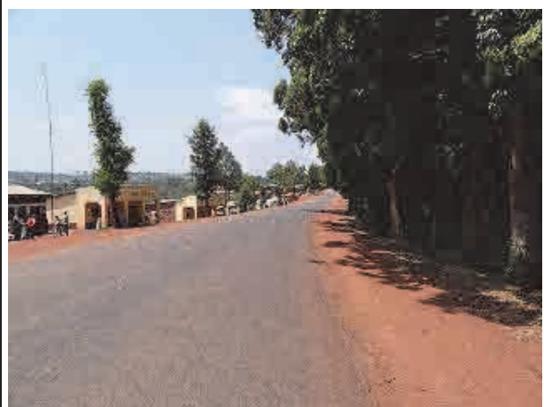
ひび割れ・剥離が進行している。
