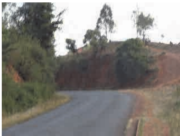
急カーブ区間であり、交通安全標識及び交通安全施設を必要とする。
