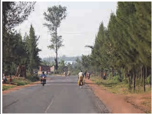
舗装修復箇所及び舗装端部にわだち。舗装端部を走行する自転車及びオートバイ
