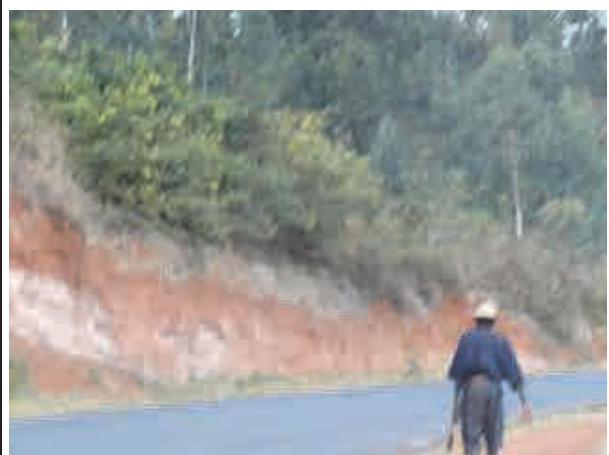
道路拡幅に伴い、法面防護を必要とする可能性のある箇所。
