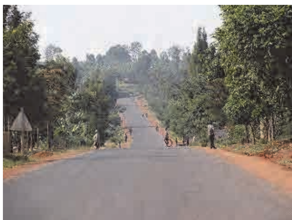
道路縦断勾配は、走行上、支障がない。
