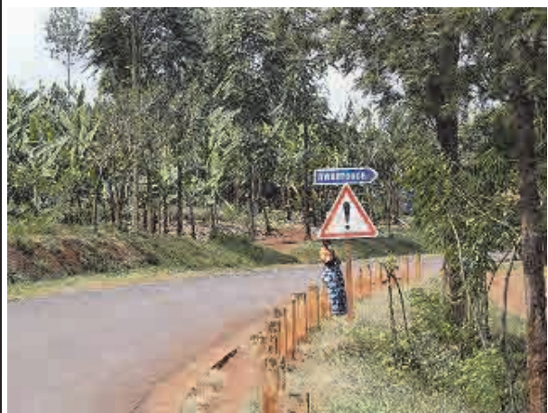
急カーブを注意するための道路標識及びガードポスト。
