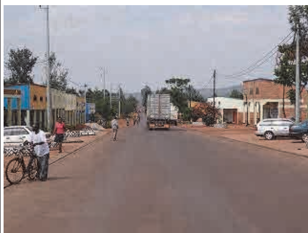
町中心部の道路区間は嵩上げされた歩道が設置されている。
