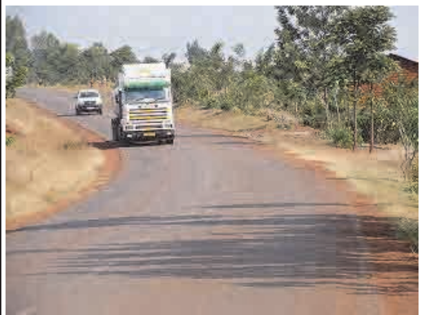
カーブ地点での大型車の安全な交互交通に支障があると思われる箇所
