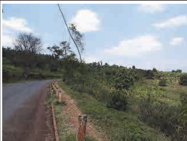
Kibungo から Rusumo への急カーブ道路。交通安全のためのガードポストが設置されているが、安全標識などによる交通安全対策を必要とする。
