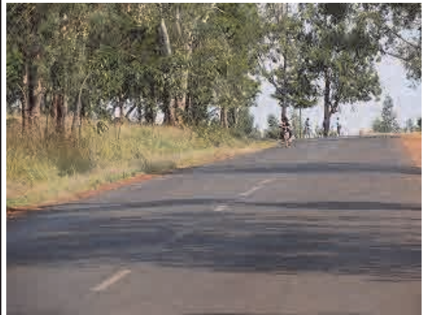
急カーブ手前で交通安全標識を必要としている。
