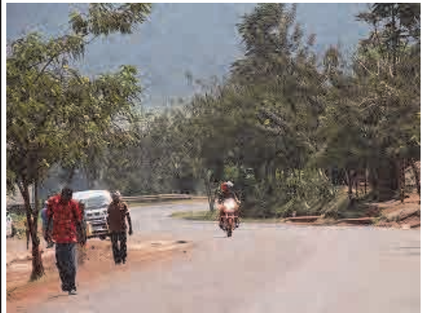
S字カーブが連続しており、交通安全上、危険な箇所
