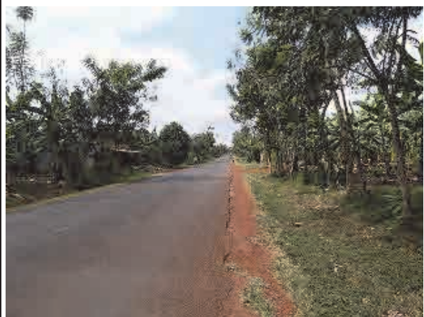
車道幅が狭く、車道拡幅を行う場合、樹木が支障となる可能性がある。
