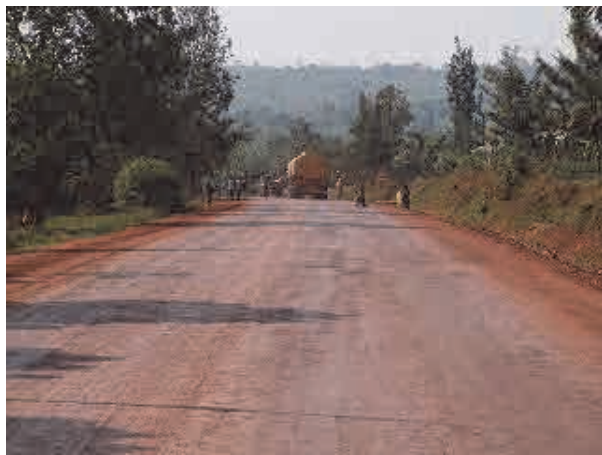
簡易舗装工事を行うため、舗装の表層を剥ぎ取った直後。
