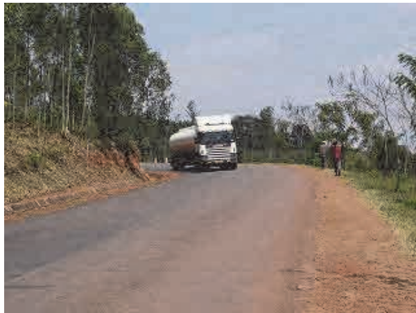
急カーブのため、道路中央部を走行するタンクローリー一車
