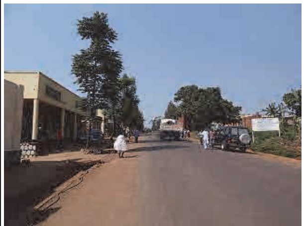
舗装表面が劣化し、ラベリングが全面に広がっている。
