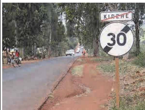
路肩が舗装されていないため、車道を走行する自転車。車が接近中。町・村区間の端部で、30 km/hr の制限速度が解除されている。
