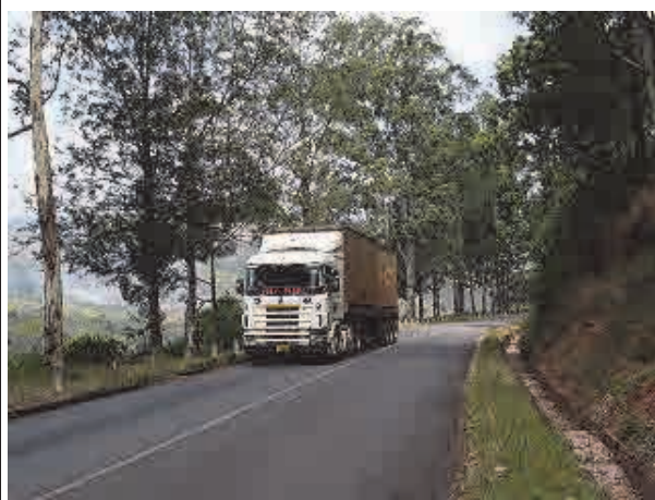
余裕のない走行車線を走行するトレーラ車。計画されている車道、路肩、排水路等を設置した場合、法面を削る可能性があり、建設費の高騰に繋がる。
