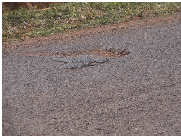
小規模のポットホールが散見される。
