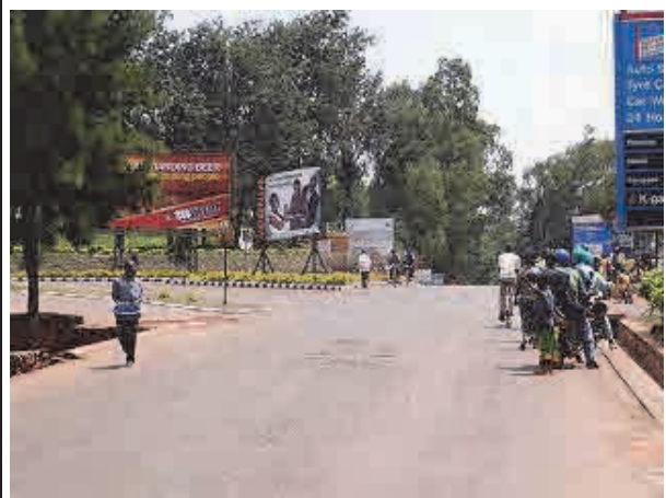
Kibungo 交差点から Kayonza 方向をみる。ひび割れが進行し、ポットホールを生じ始めている。
