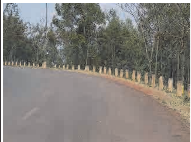
カーブの危険個所に設置されたガードポスト
