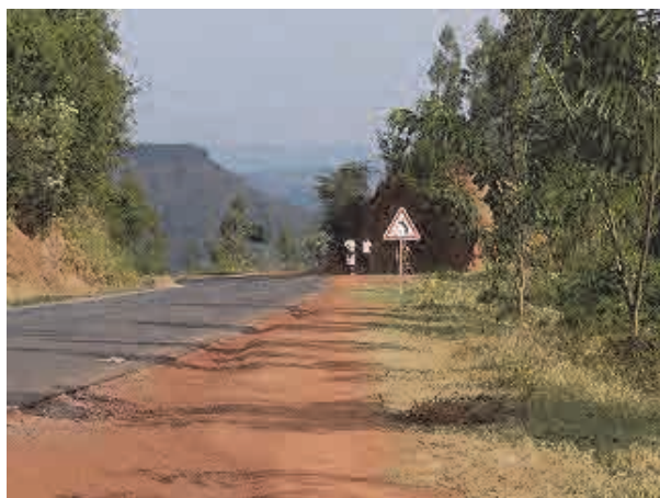
急カーブに対する交通安全標識がある。交通安全施設も併せて必要とする。
