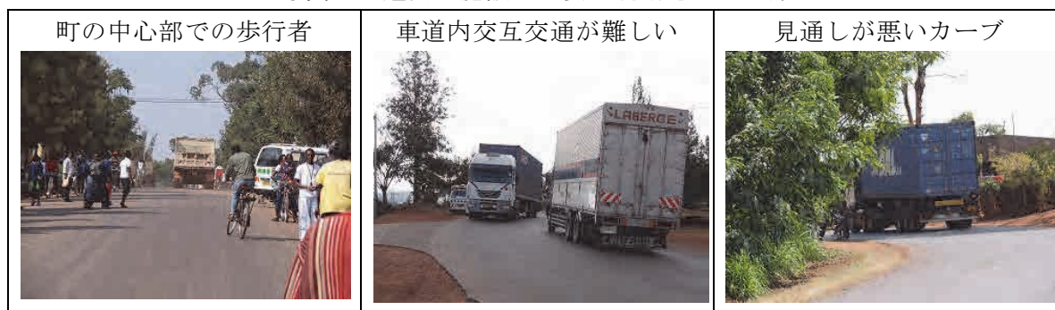
写真 交通安全施設が必要と判断される道路
