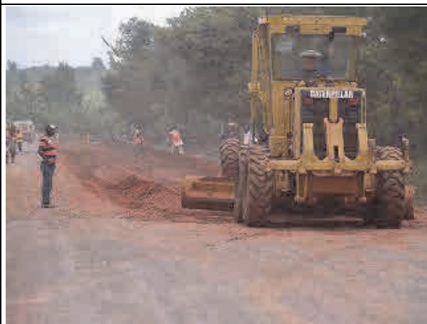
簡易舗装による補修状況
