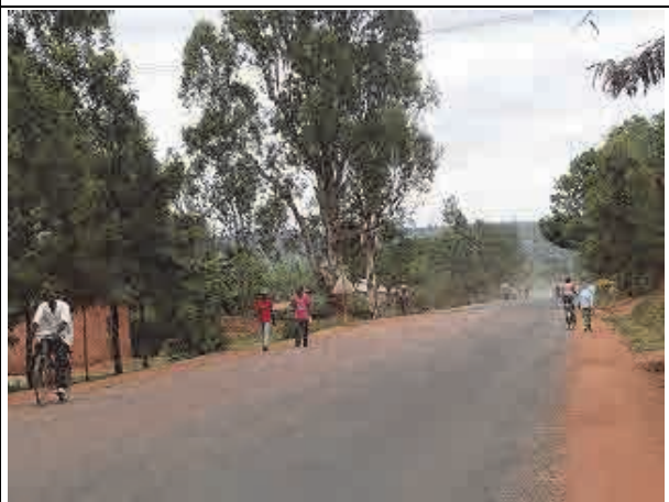
簡易舗装による補修直後
