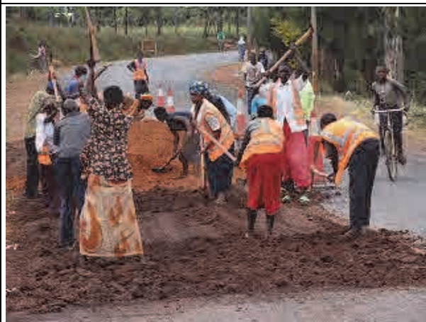
住民参加による舗装補修状況
