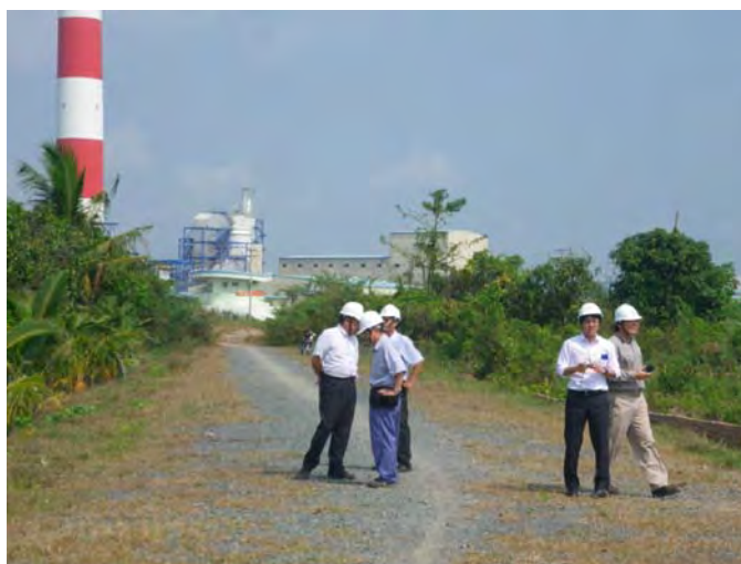
写真 4.1-2 ガス分配センターよりオモン発電所を望む
