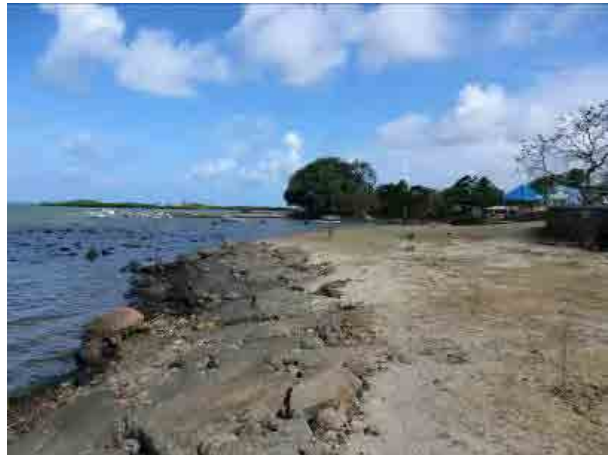
図 2-302 ReCoMap-IO により実施された緩傾斜型石積護岸工および背後の植栽工
