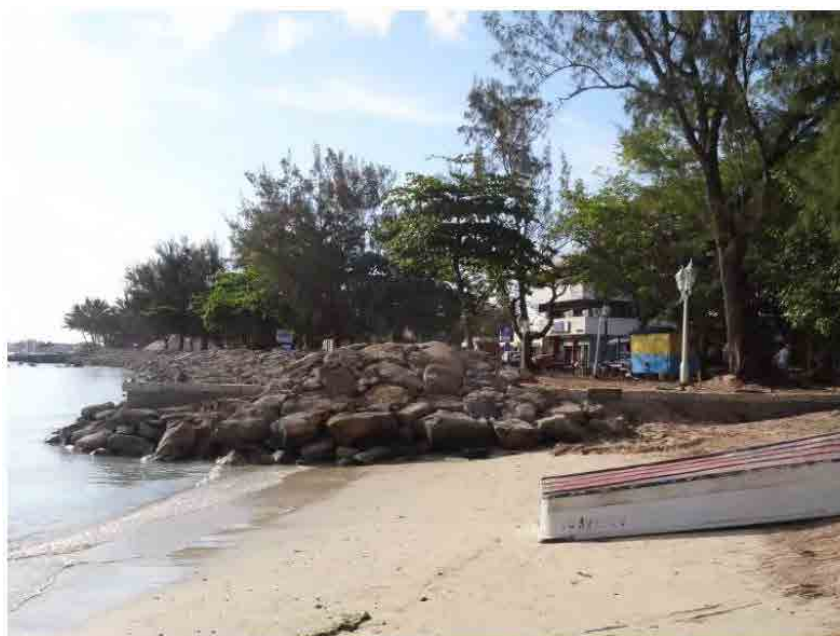
図 1-4 Grand Baie の石積護岸 (撮影 2011/11/22)
