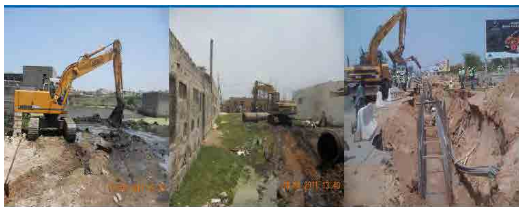
図 3-1-1 プラン・ジャハイによる緊急対応排水管の整備
