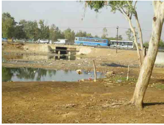
(7) エンバオ川下流より国道1号線橋梁を望む。
