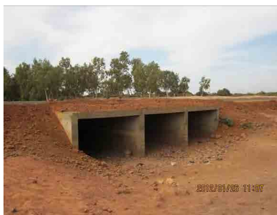
(18)エンバオ川、橋梁（建設中の高速道路横断部）
