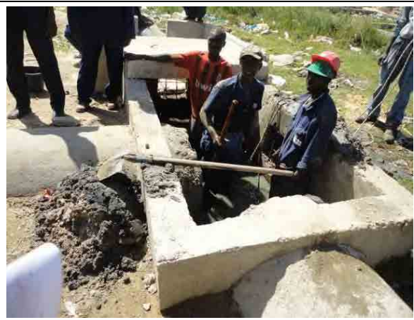
(2) 閉塞した埋設管路の浚渫状況
