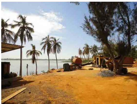
(5) ポンプステーション（Woui 湖）
