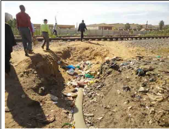
(1) 氾濫雨水を海へとポンプ圧送するための埋設パイプ：ダリフル地区 鉄道線路地点
