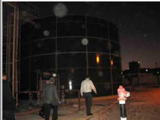
インター・コンチネンタル・ホテルの汚水 処理施設
