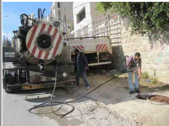
ナブルス市 下水管路の清掃現場
