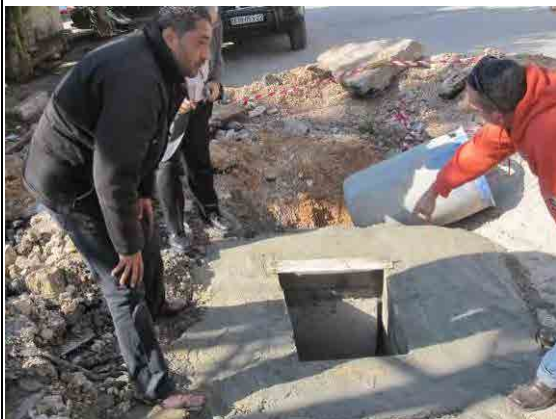
ナブルス市 マンホールの施工現場
