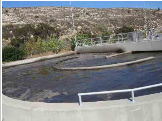
アル・ビーレ下水処理場（反応槽）
