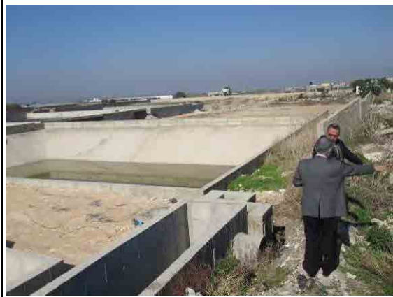
ジェニン市の改築中の下水処理場
