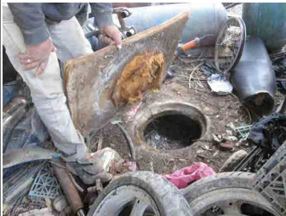
家屋敷地内の浸透槽（セスピット）
