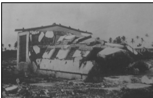
写真 - 1.1.2-3 リッジ背後の発電施設 (15mの高波で被災)
