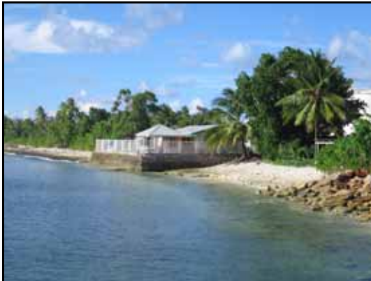
写真 - 1.4.2-7 フナフチ港北側の埋立地
