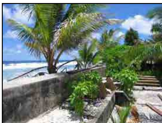
写真 - 1.4.1-16 私設海岸堤防の状況
