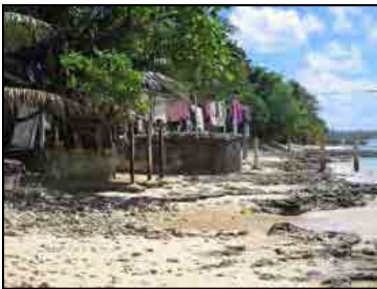
写真 - 1.4.2-25 海岸部の埋立地の状況
