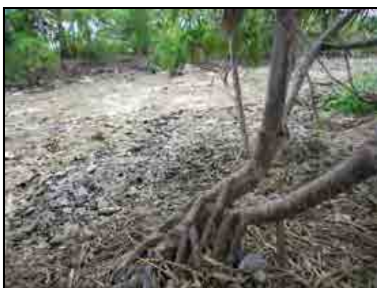
写真 - 1.4.1-3 越波による土採場への栗石の流入
