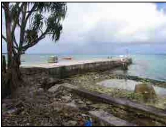
写真 - 1.4.2-21 政府庁舎裏の旧岸壁の状況
