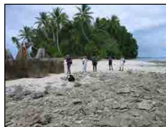
写真 - 1.4.1-4 北端部の状況
