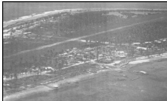
写真 - 1.1.2-2 政府庁舎の周辺
