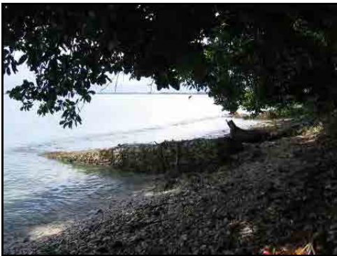
写真⑪ 工事中の埋立地
