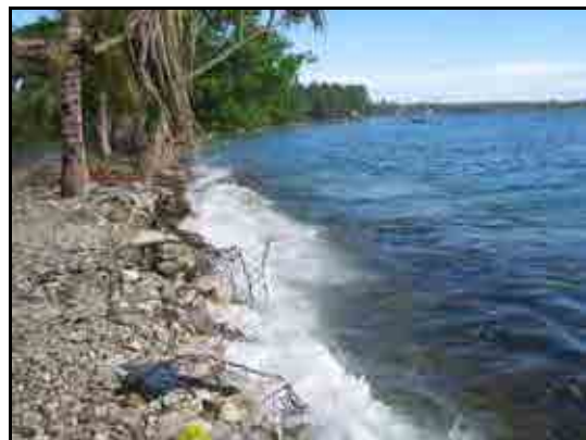
写真 - 1.4.2-6 高潮時の蛇籠による護岸工
