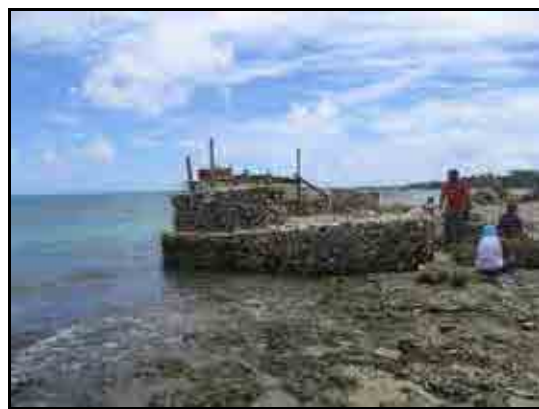
写真 - 1.4.2-26 海岸部の建設中の埋立地
