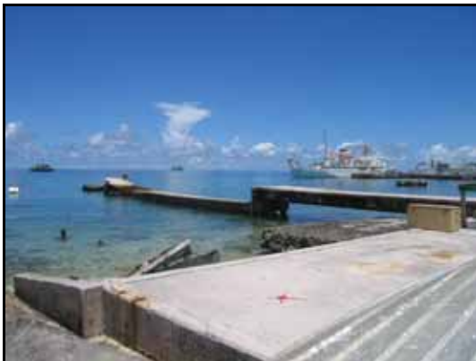
写真 - 1.4.2-9 フナフチ港南側の漁港棧橋
