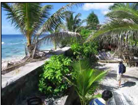
写真⑮ 南部の私設海岸堤防
