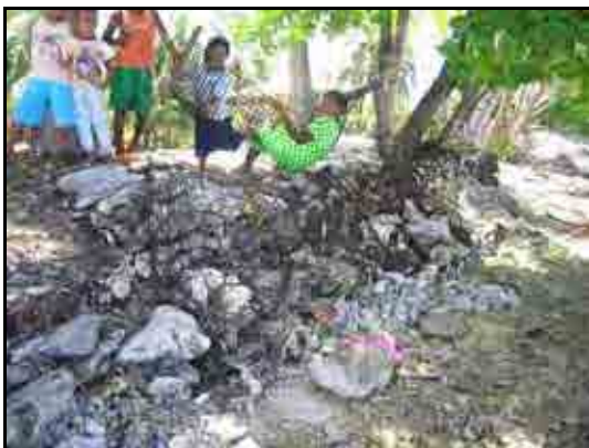
写真 - 1.4.2-5 低潮時の蛇籠による護岸工
