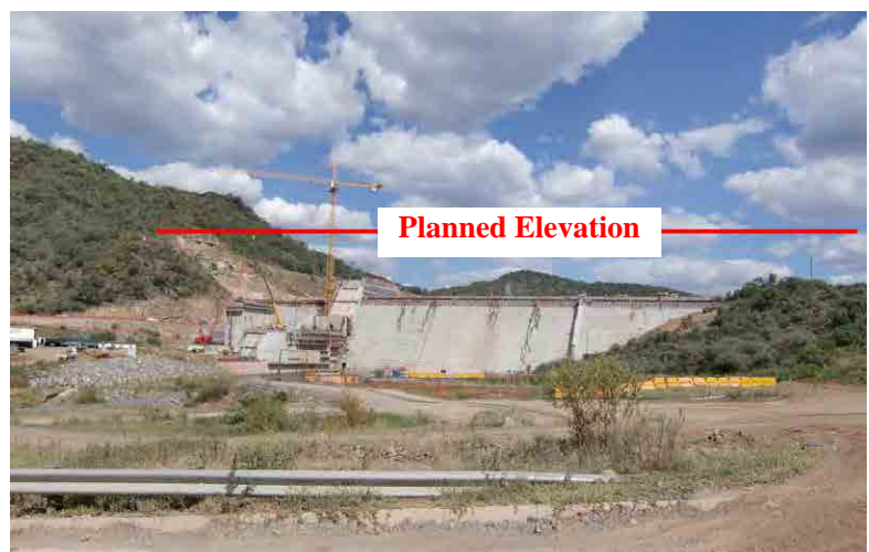
図 2.3-1 建設中の De Hoop ダム
