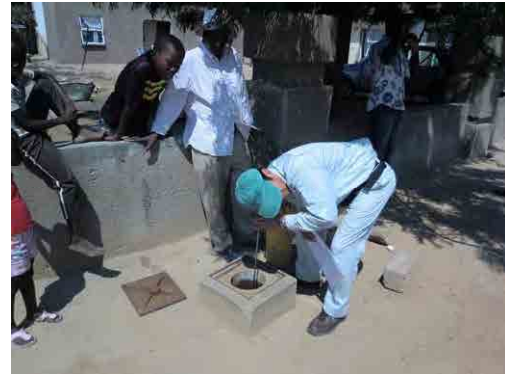
図 4.3-4 バルブ制動不良
