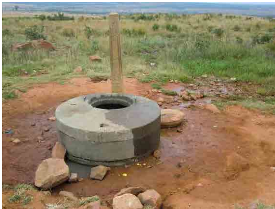
図 9.5-1 空気弁室における盗水の痕跡
