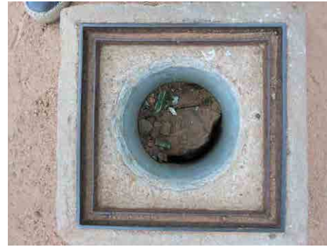
図 4.3-3 バルブ・ヘッドの埋没
