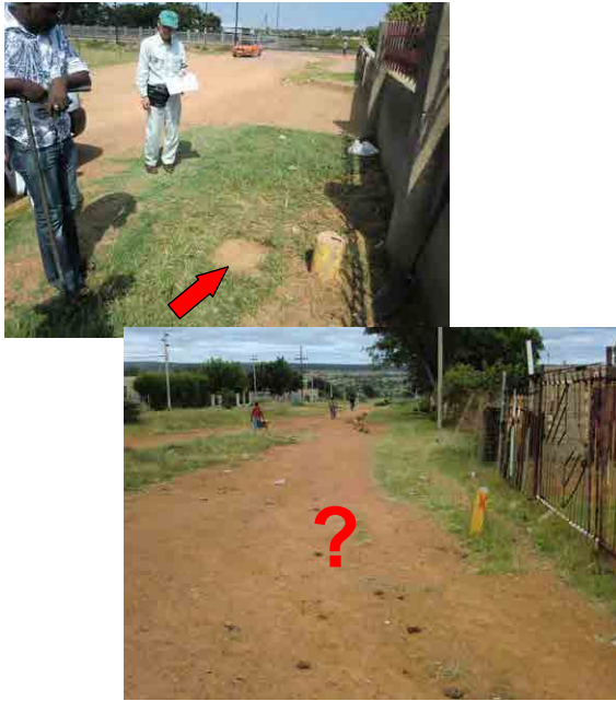
図 4.3-2 既存バルブの埋没
