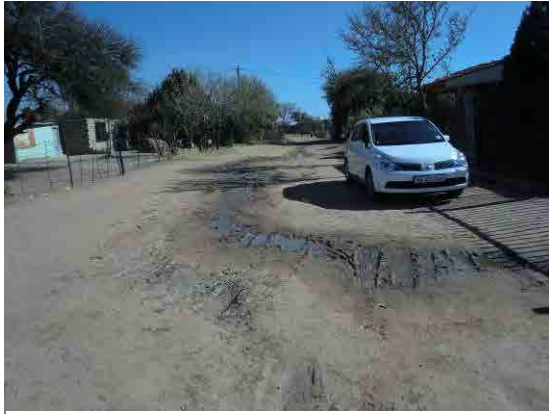
図 9.4-1 地表に浸出した漏水
