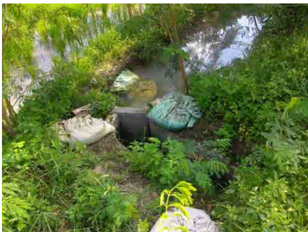
2次調査でのポーラック・グマイン灌漑システムの支線水路から末端水路への分岐部の状況。IA（水利組合）の手により土嚢で機能維持が図られている。
