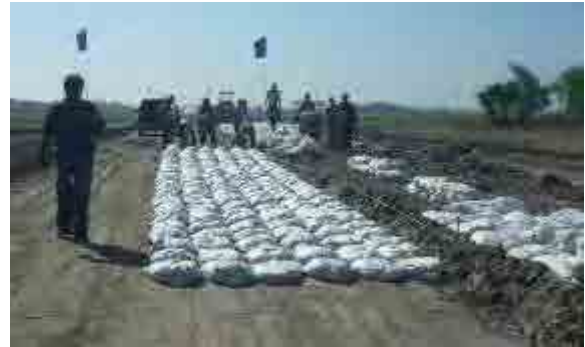
土嚢試験区間約 100m
