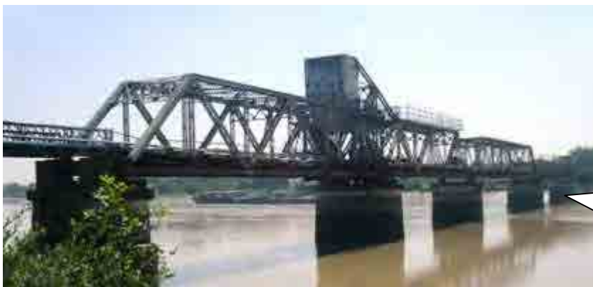
Tharkyata 橋 (50 年以上前のもの) 上部の構造物は開閉用装置
