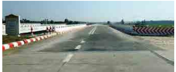
NayPyiTaw の南 橋梁取付部 ASで補修
