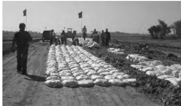
土嚢試験区間約100m
