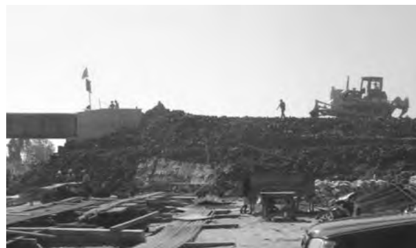
アプローチ部分高さ(8m)の盛土工事状況
