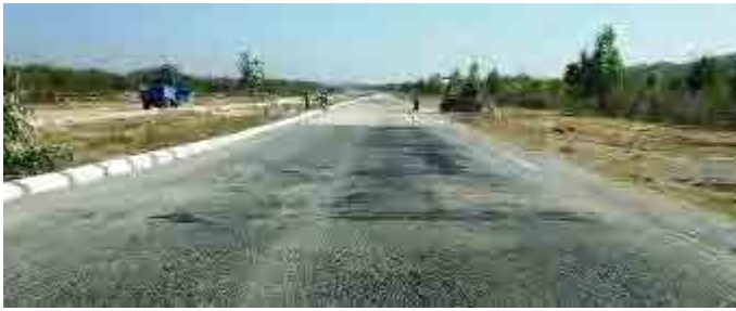
距離標 179 付近沈下部の補修
