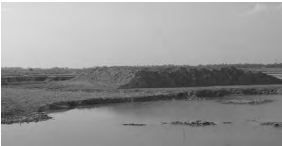
3号線沿いの避難用盛土
