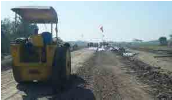
11 号線土嚢路盤試験工事区間
