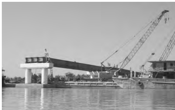
Pay Pin Nyaiait 橋 鋼製桁(日本製鉄)架設
