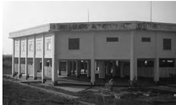
2階部分 約 500m 2 +屋上 未だ供用実績なし
