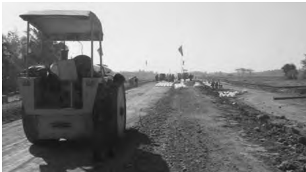
11号線土嚢路盤試験工事区間
