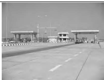
Nay Pyi Taw 料金所(アクセスは工事中)
