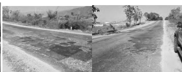
検査の結果オーバーレイが必要とされた舗装の状態
