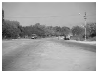
料金所付近の道路状況
