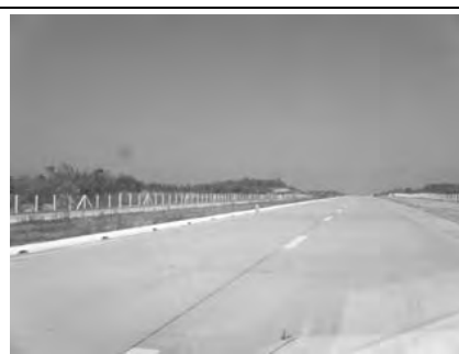
未施工の中分(縁石は非常に簡素)
