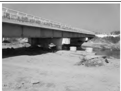
拡幅用橋脚下部施工済み
