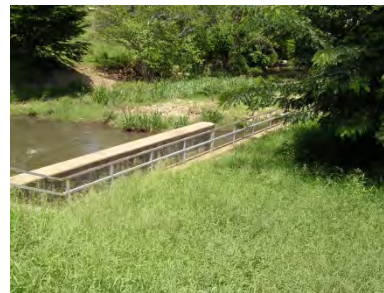
ヌドゥングの頭首工
