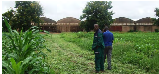
元キリマンジャロ農機サービスセンター
