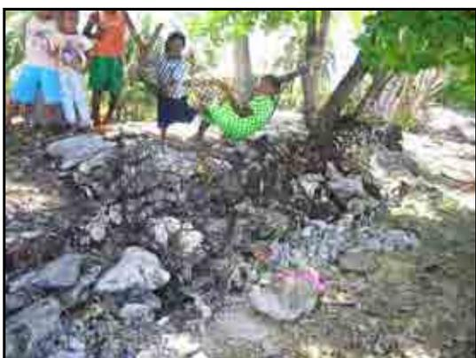
写真 - 1.4.2-5 低潮時の蛇籠による護岸工
