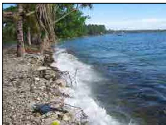
写真 - 1.4.2-6 高潮時の蛇籠による護岸工
