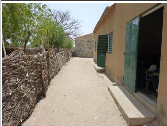
校舎と仮設施設の囲い塀 穀物倉庫を校舎として間借りしている。 (KA-10M カオラック州 インゴルム中学校)
