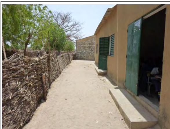
校舎と仮設施設の囲い塀 穀物倉庫を校舎として間借りしている。 (KA-10M カオラック州 ンゴルム中学校)
