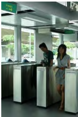
Gambar 6.4.30 Sistem gerbang tiket dengan pintu putar tertutup
