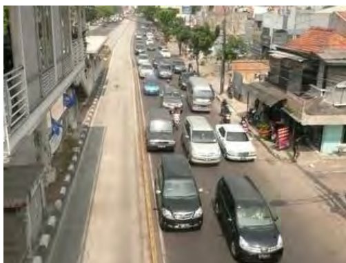
Gambar 6.4.3 Satu Jalur BRT dengan 3 Jalur Kendaraan Tanpa Trotoar
