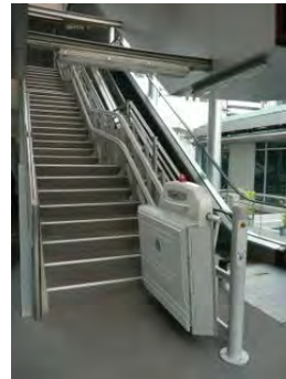
Gambar 6.4.19 Sebuah lift kursi roda melekat pada handrail
